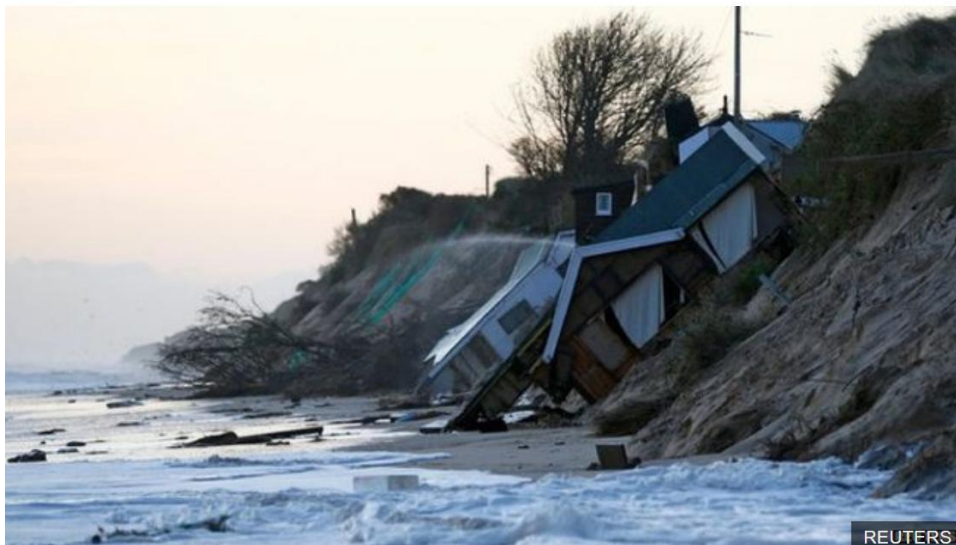
Εικόνα 2-14: Hemsby, on the Norfolk coast, UK (05.12.2013). «Επτά κατοικίες πλησίον της ακτής κατέρρευσαν της νύχτα της μεγάλης κακοκαιρίας» [Πηγή: www.bbc.com ]
