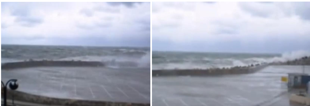
Εικόνα 4-8: Περιοχή Ρεθύμνου (11.12.2010). «Κυματική υπερπήδηση στην περιοχή του χώρου στάθμευσης και του προσήνεμου μώλου του λιμένα Ρεθύμνου» [Πηγή: https://www.youtube.com/watch?v=jdY8qKaZS5w ]
