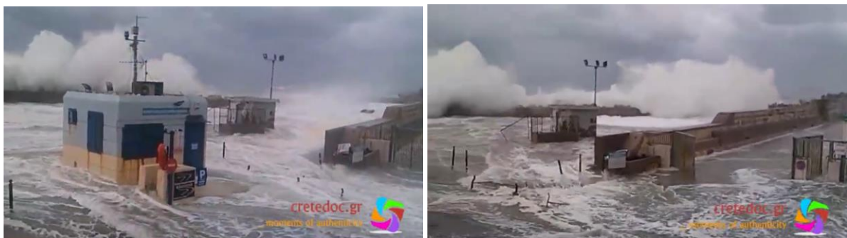
Εικόνα 4-11: Περιοχή Ρεθύμνου (13.01.2015). «Τα κύματα υπερπηδούν τη θωράκιση και πλημμυρίζει η περιοχή του λιμένα Ρεθύμνου» [Πηγή: https://www.youtube.com/watch?v=dq6R24HSA1s ]
