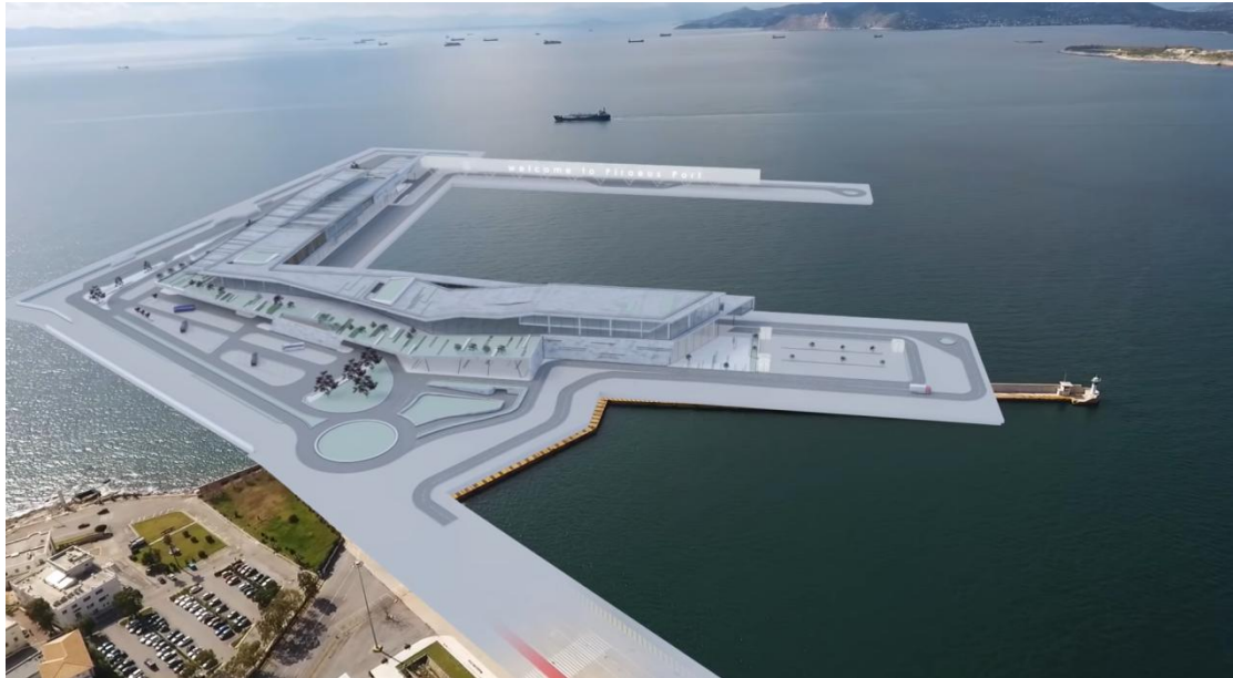
Εικόνα 39. Ο νέος Σταθμός Κρουαζιέρας του Λιμένα Πειραιά στην τελική μορφή του Πηγή: ΕΥΔ ΕΠ Αττικής
