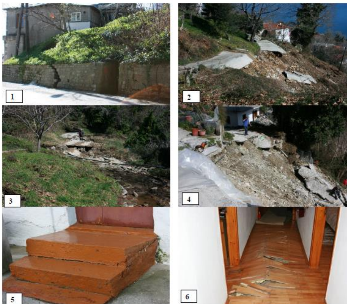
Εικόνα 3.9: Φωτογραφίες κατολισθήσεων στην περιοχή με αντιστοιχία αριθμών του πίνακα 3.6 (ΙΓΜΕ, 2018)
