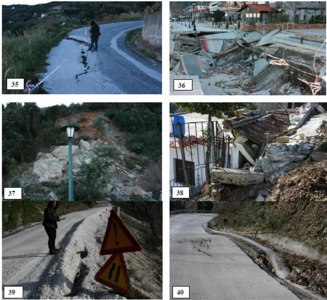
Εικόνα 3.12: Φωτογραφίες κατολισθήσεων στην περιοχή με αντιστοιχία αριθμών του πίνακα 3.6 (ΙΓΜΕ, 2018)
