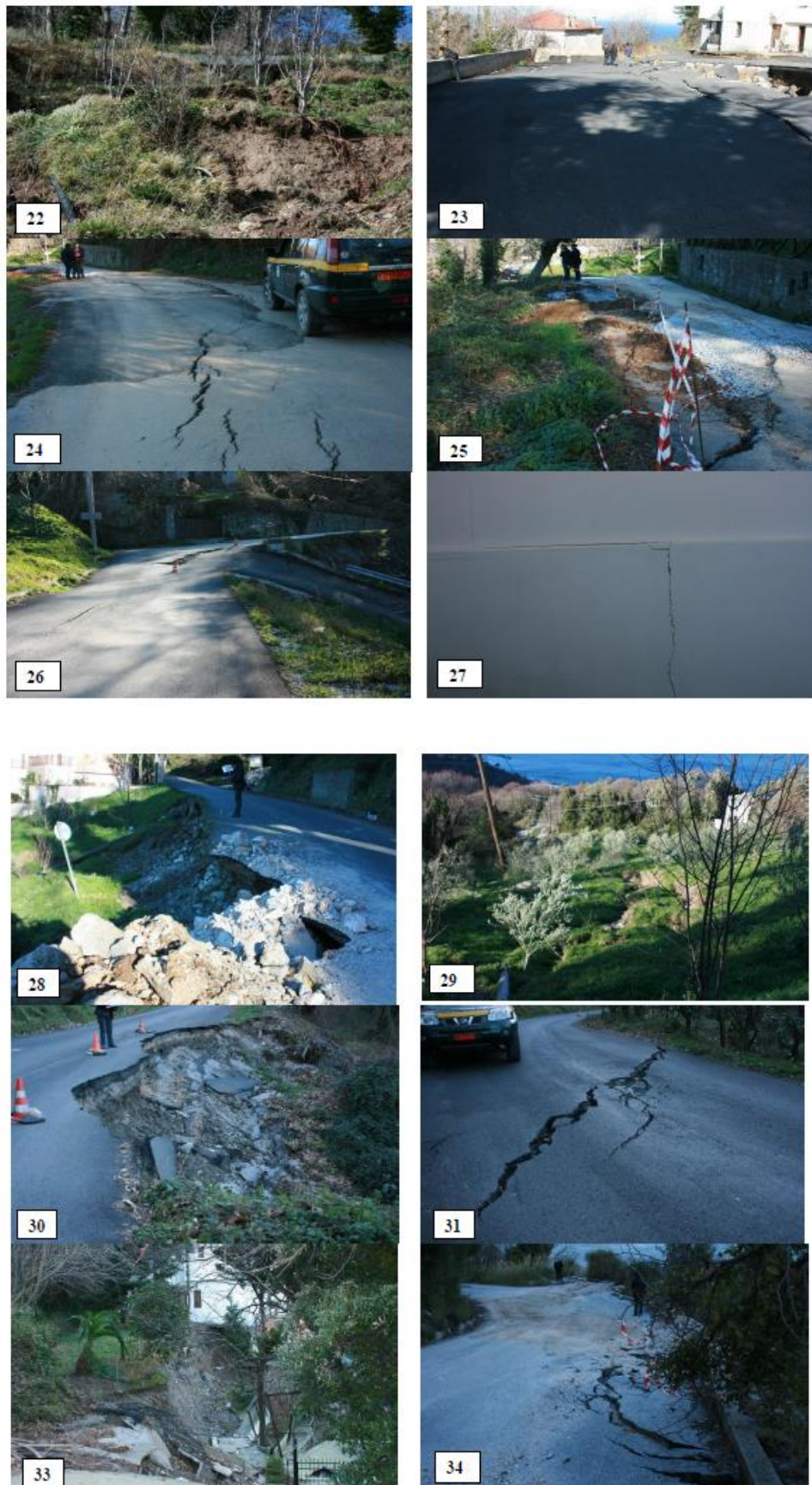
Εικόνα 3.11: Φωτογραφίες κατολισθήσεων στην περιοχή με αντιστοιχία αριθμών του πίνακα 3.6 (ΙΓΜΕ, 2018)
