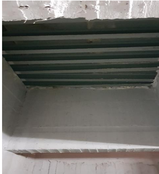
Εικόνα 97 Καταπακτή εισόδου – εξόδου μηχανημάτων με κοιλοδοκούς
