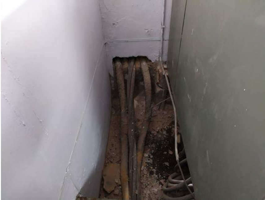
Εικόνα 93 Ειδικό κανάλι για όδευση των καλωδίων
