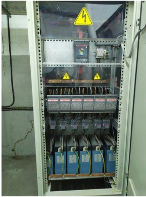
Εικόνα 128 Πυκνωτές Ιδιώτη για ρύθμιση συνημίτονου
