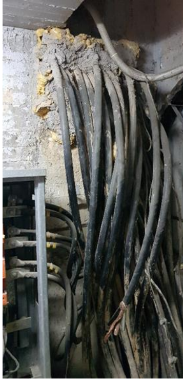
Εικόνα 102 Όδευση καλωδίων Χαμηλής Τάσης από τον χώρο του Υ/Σ προς τους καταναλωτές
