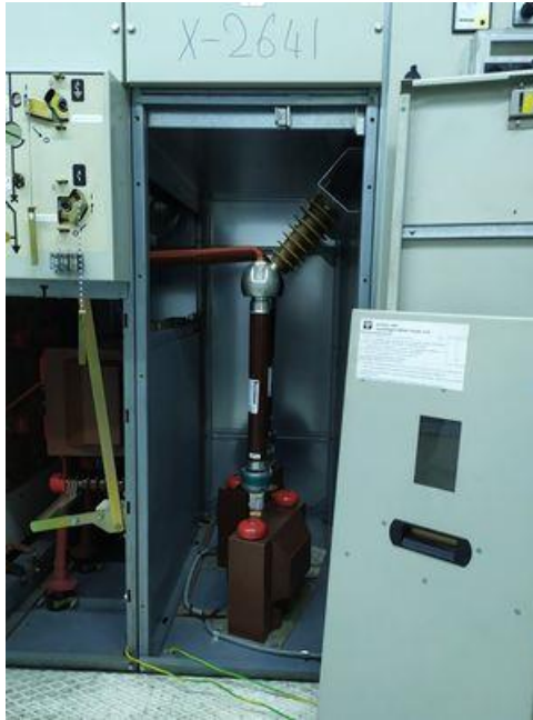
Εικόνα 116 Μετασχηματιστές
