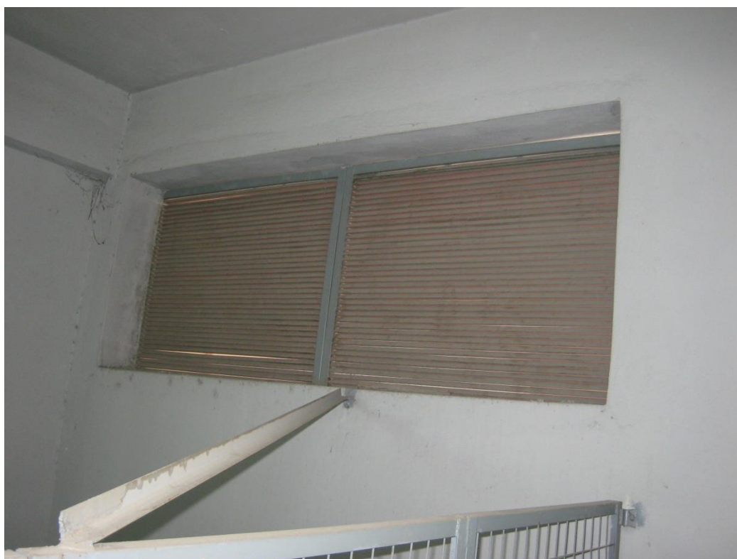
Εικόνα 25 Θυρίδες εξαερισμού σε Υ/Σ Πόλεως
