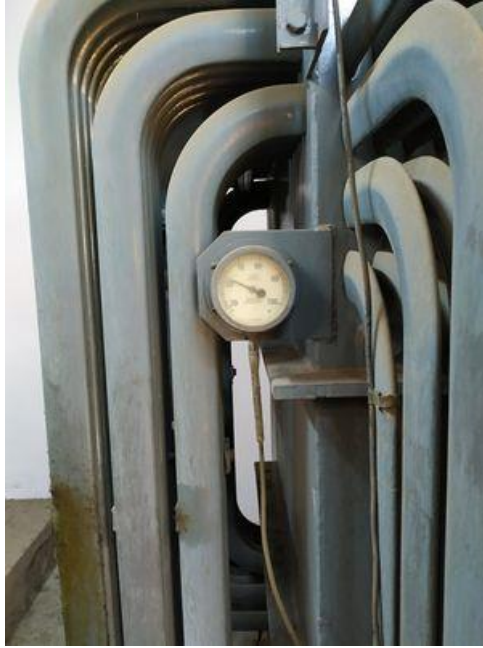
Εικόνα 81 Θερμόμετρο ελαίου Μ/Σ
