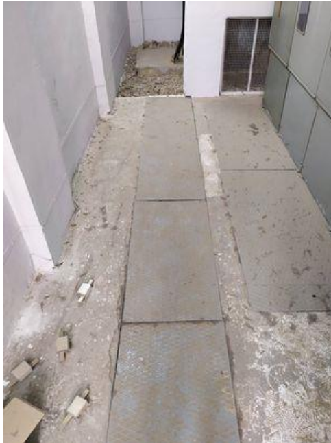
Εικόνα 92 Ειδικό κανάλι για όδευση των καλωδίων
