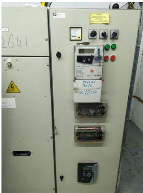
Εικόνα 117 Μετρητική διάταξη
