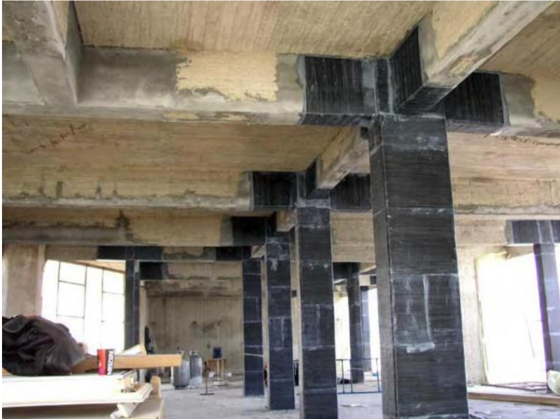
Εικόνα 5.12: Τοποθέτηση υφασμάτων ινοπλισμένων πολυμερών σε υποστυλώματα και κόμβους.
