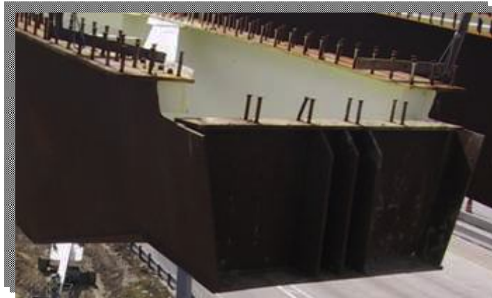
Φωτογραφία 3: Διπλό Διάφραγμα που θα τοποθετηθεί σε θέση στήριξης
