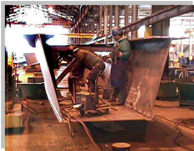
Φωτογραφία 1: Κατασκευή Κιβωτίου
