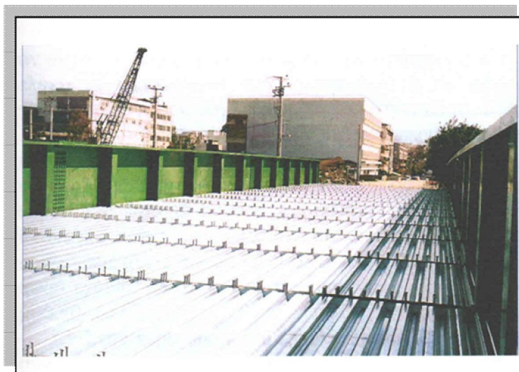
Φωτογραφία 4 : Διάταξη σύμμικτης πλάκας γέφυρας από χαλυβδόφυλλο και διατμητικούς ήλους σύνδεσης προ διάστρωσης με επί τόπου έγχυτο σκυρόδεμα
