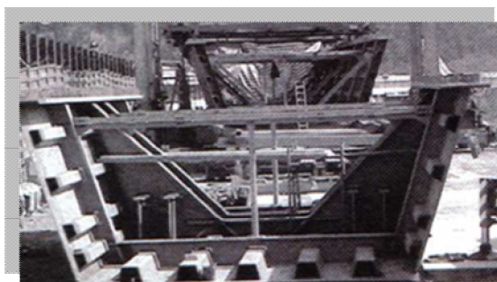
Φωτογραφία 2: Διαμήκεις και εγκάρσιες ενισχύσεις κιβωτίου
