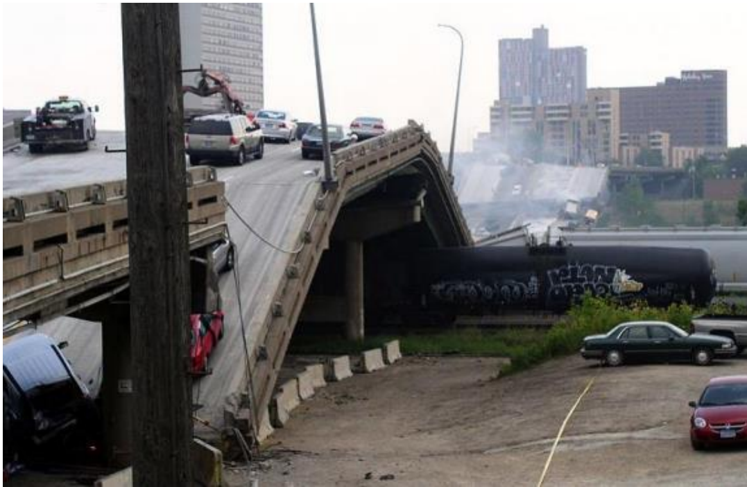
Εικόνα 10: Σύνηθες αστοχίες λόγω διάβρωσης παρατηρούνται σε γέφυρες, με την κατάρρευση των οποίων παρουσιάζεται και πολύ μεγάλη επικινδυνότητα .
