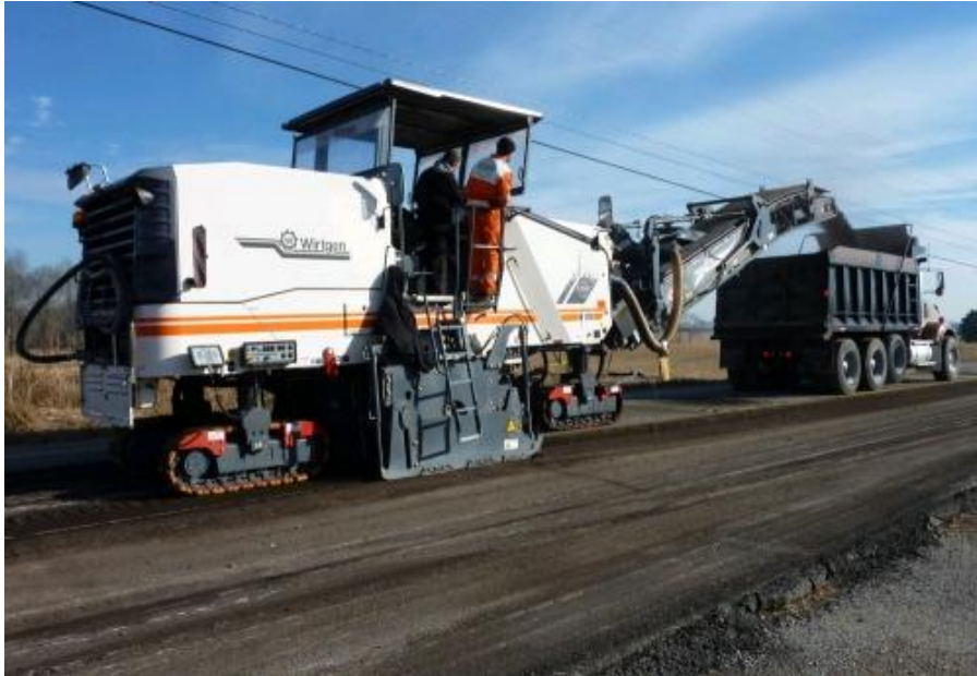
Φώτο 9.2. Surface Miner σε λειτουργία
