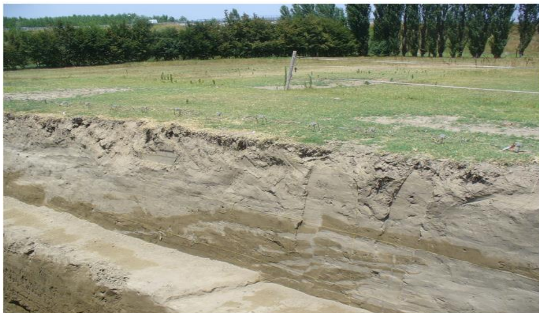
Εικόνα 49. Φωτογραφία της τάφρου που εντοπίζεται στο πεδίο έρευνας στο Mirabello και στην οποία είναι εμφανείς ασυνέχειες λόγω της ρευστοποίησης
