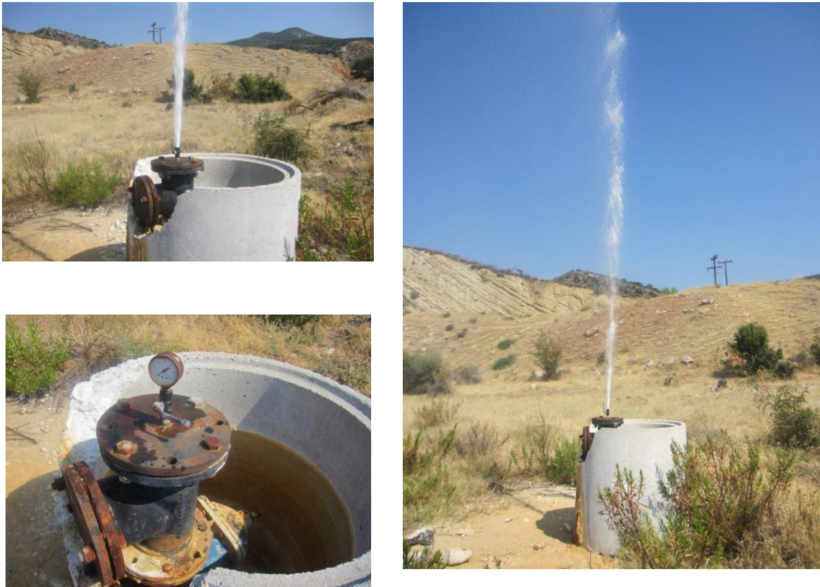
Εικόνα 1 Φωτογραφίες γεώτρησης στην περιοχή του Ακροποτάμου(ΑΚΡ-1)
