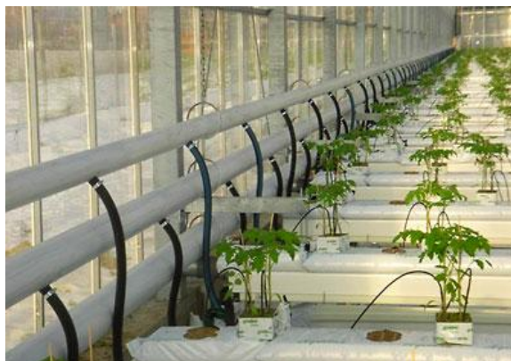
Σχήμα 4. Σύστημα θέρμανσης θερμοκηπίων με γεωθερμία [31]
