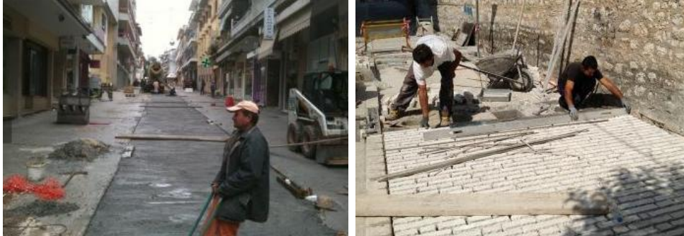
Εικόνα 29: Έργα πεζοδρόμησης οδών στην πόλη και το ιστορικό κέντρο των Ιωαννίνων
