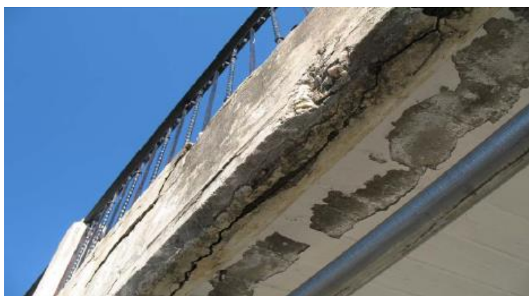
Σχήμα 2.4.1. Ομοιόμορφη διάβρωση (Κουρνέτας, Φεβρουάριος 2010)
