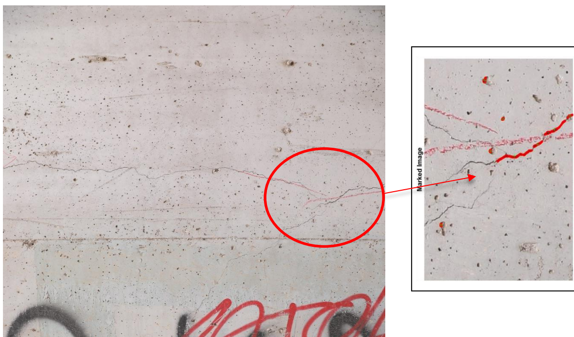
Σχήμα 7.2.1. Αρχική εικόνα και υπο-εικόνα εστιασμένη στη ρωγή-1 η σειρά μετρήσεων
