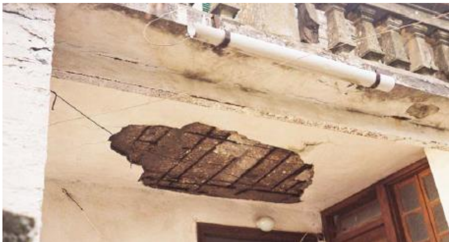
Σχήμα 2.4.2. Τοπική Διάβρωση (Κουρνέτας, Φεβρουάριος 2010)
