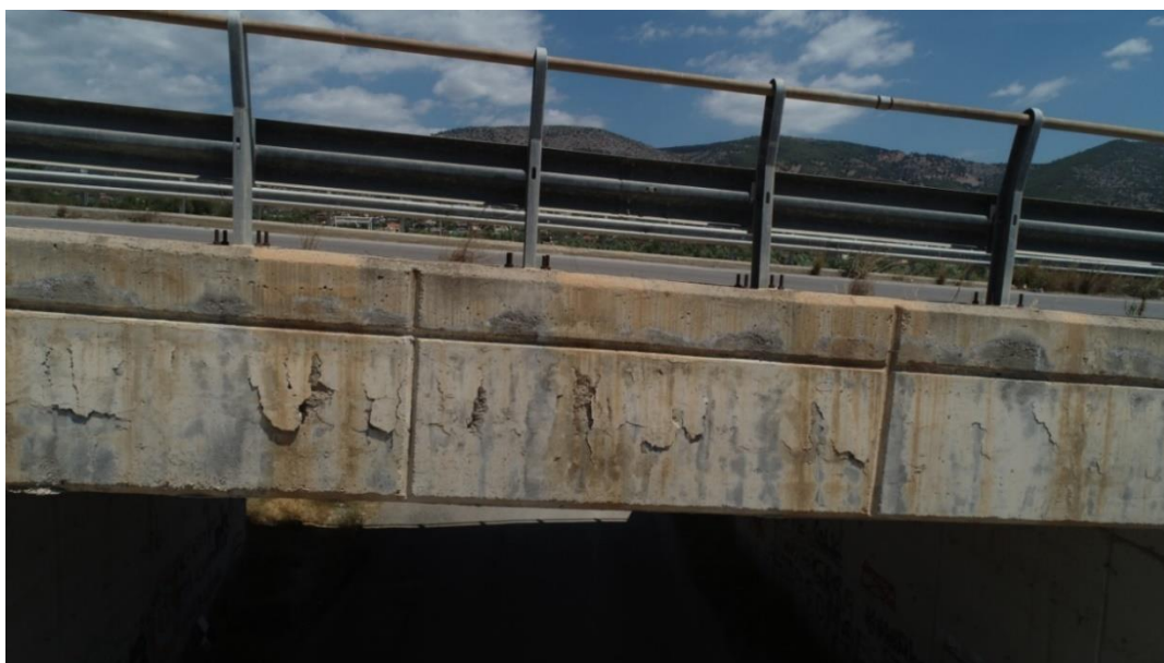
Σχήμα 7.3.3. Εικόνα από Drone, Γέφυρα Νέας Περάμου
