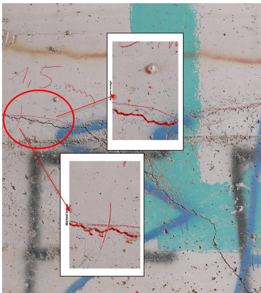
Σχήμα 7.2.2. Αρχική εικόνα και υπο-εικόνες με ρωγμές- 2 η σειρά μετρήσεων
