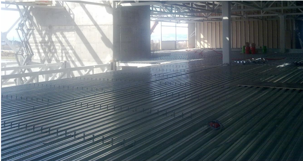
Εικόνα 3.6 Χαλυβδόφυλλα και διατμητικοί σύνδεσμοι
