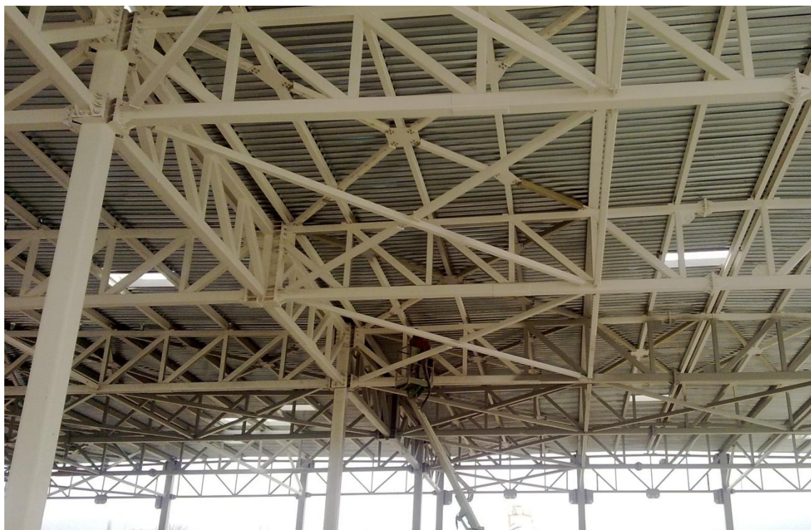
Εικόνα 3.2 Οριζόντιοι σύνδεσμοι δυσκαμψίας στο επίπεδο των κάτω και άνω πελμάτων των δικτυωμάτων οροφής
