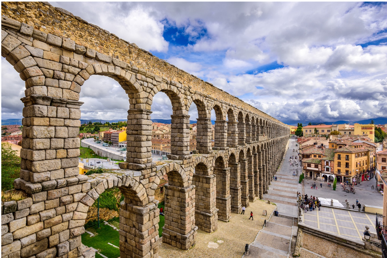
Εικόνα 10: Το Ρωμαϊκό Υδραγωγείο της Σεγονία στην Ισπανία. Διακρίνεται η λιθοδομή από κατάλληλα πελεκημένες πέτρες και η συμπλήρωση της οικοδομής με πλίνθους και χυτό υλικό. Η εικόνα προέρχεται από τον ιστότοπο Britannica.com
