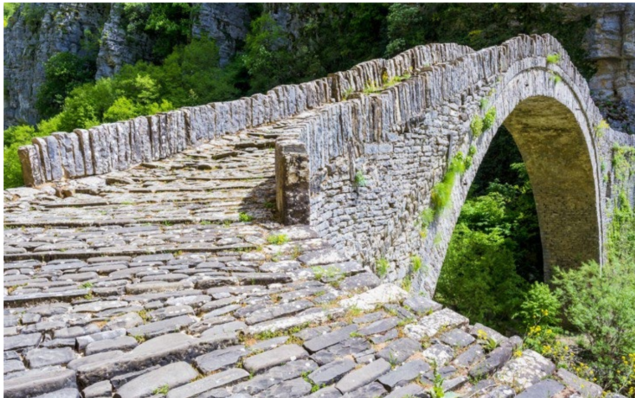
Εικόνα 11: Το γεφύρι του Κόκκορη, πάνω από το ρέμα Βικάκι (που παρακάτω γίνεται Βοϊδομάτης) κοντά στους οικισμούς Κουκούλι και Κήποι του Ζαγορίου, στον νομό Ιωαννίνων. Παρατηρεί κανείς τα στηθαία που ακολουθούν το τόξο του γεφυριού (αρκάδες), την λεπτότητα της οικοδομής αλλά και το επιμελώς στρωμένο καλντερίμι επί της γέφυρας. Η φωτογραφία λήφθηκε από τον ιστότοπο gropnews.gr
