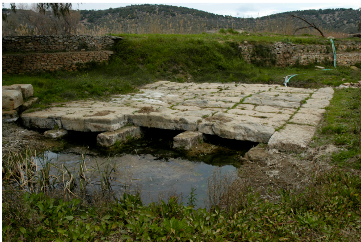
Εικόνα 9: Η γέφυρα αυτή βρίσκεται στον αρχαιολογικό χώρο της Βραυρώνας, όπου και το ιερό της Βραυρώνιας Αρτέμιδος. Η τεχνοτροπία της γέφυρας ακολουθεί το σύστημα δοκού επί στύλου, αλλά το δομικό υλικό της είναι πέτρες κατάλληλα διαμορφωμένες αντί ξύλου. Η εικόνα προέρχεται από τον ιστότοπο gtr.gr
