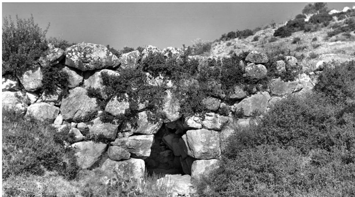
Εικόνα 8: Η Γέφυρα της Καζάρμας στο Αρκαδικό Αργολίδος. Διακρίνεται η μυκηναϊκή τεχνοτροπία της αργολιθοδομής με ελάχιστη επεξεργασία, αλλά προσεκτική τοποθέτηση των μεγάλων λίθων. Η εποχή της ανέγερσης υπολογίζεται στον 14 ο – 13 ο αι. π.Χ. η φωτογραφία προέρχεται από τον ιστότοπο ellinondiktvo.blogspot.com
