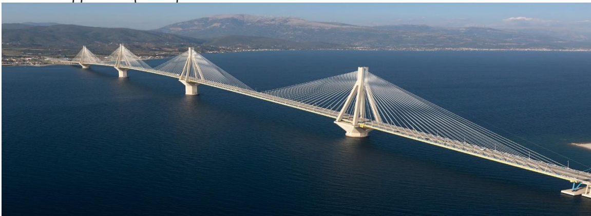
Εικόνα 4.3: Γέφυρα Ρίου-Αντιρρίου, στην Πάτρα
