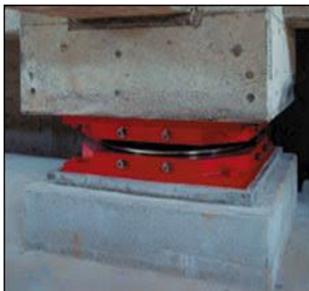
Σχ. 2.2 FPS εφέδρανο ολίσθησης τύπου εκκρεμούςς
