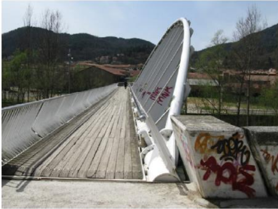
Εικόνα 3-2: Πεζογέφυρα La Devesa 2
