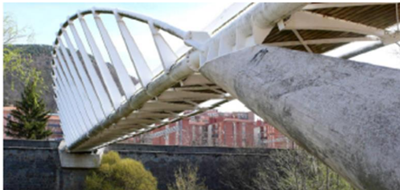
Εικόνα 3-1: Πεζογέφυρα La Devesa 1
