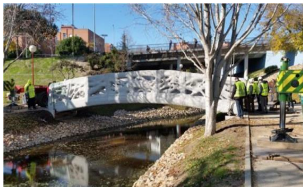
(α) Κατασκευή με τεχνολογία D-Shape
