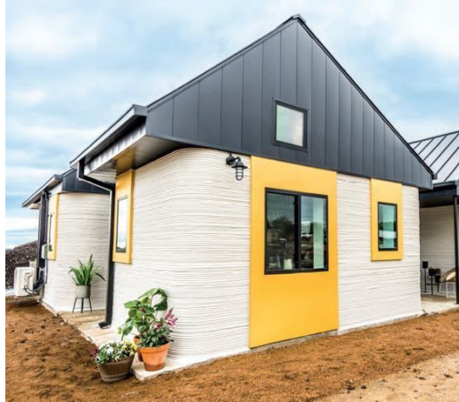
Εικόνα 2.1-11. Σπίτια 400 τ.μ. κατασκευασμένα με τον Icon's Vulcan II
