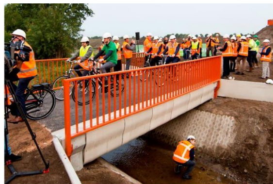
(β) Κατασκευή με τεχνολογία CC
