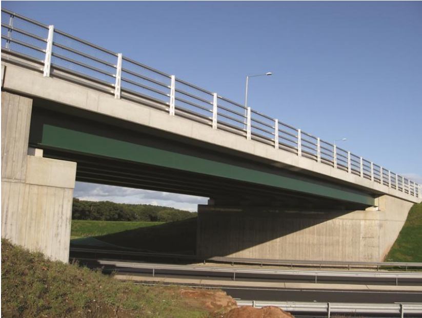
Σχήμα 1.4- Αμφιέριστη Γέφυρα με Σύμμεκτο Κατάστρωμα
