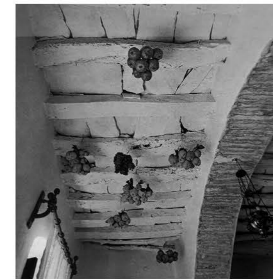
Ξύλινα δοκάρια- τράβες οροφής (Πηγή: Κουρουπάκη, Σάββαρη, Σταθάκη- Σπηλιοπούλου, & Τσαμτσούρη, 1981)
