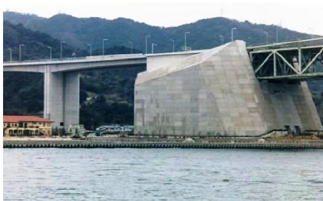
Εικόνα 1.2 Βάσεις αγκύρωσης της γέφυρας Akashi-Kaikyo (Ιαπωνία, Απρίλιος 1998). Στη συγκεκριμένη γέφυρα χρησιμοποιήθηκαν 290.000m 3 ΑΣΣ, με το χρόνο κατασκευής να μειώνεται κατά 20% από 2,5 σε 2 χρόνια.
