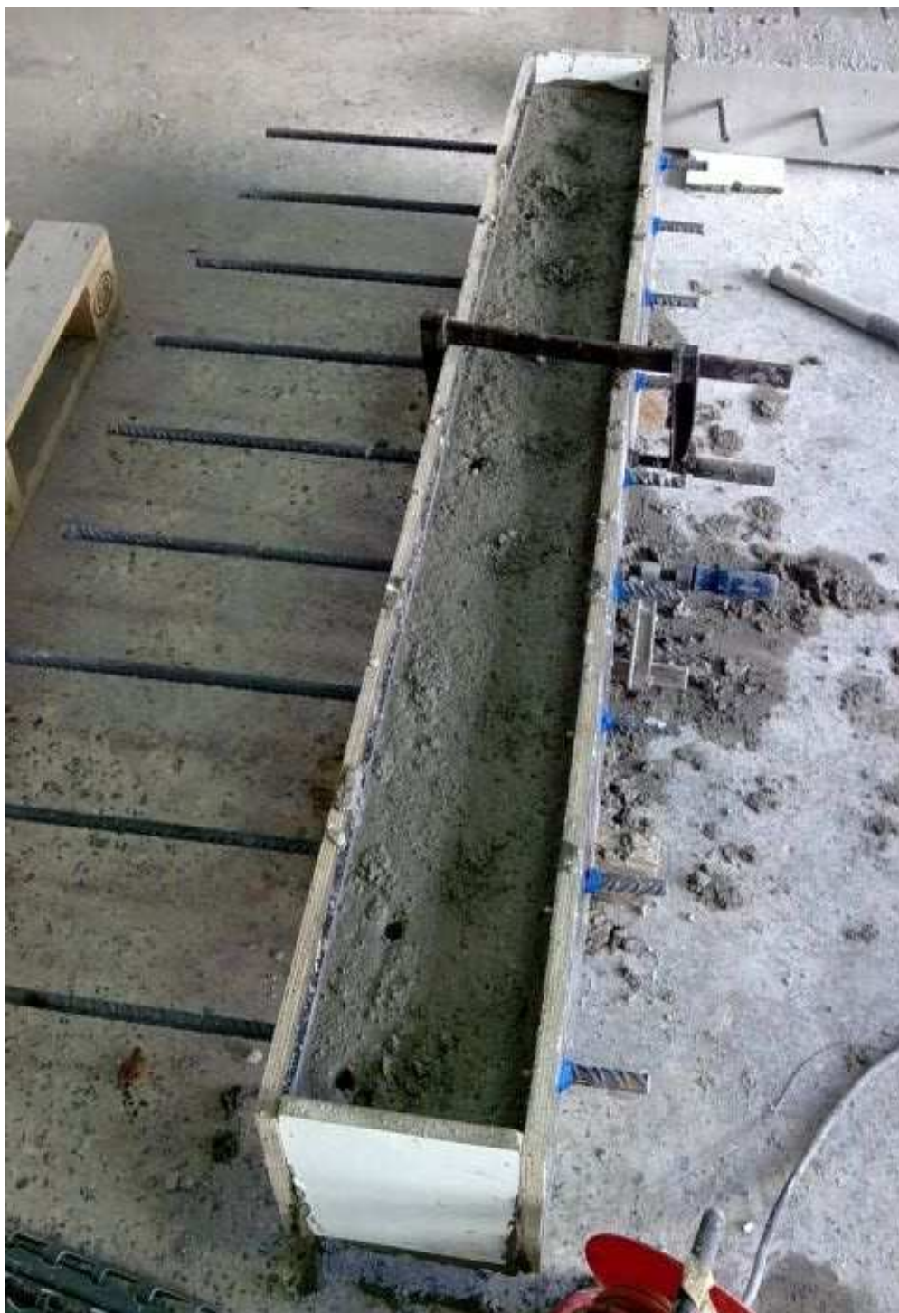
Εικόνα 2.7 Δοκίμο δοκού λίγο μετά τη σκυροδέτηση.
