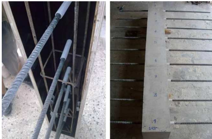
Εικόνα 1.31 Συναρμολόγηση ξυλοτύπου, τοποθέτηση οπλισμών (αριστερά), (Β) Υποστύλωμα σε κατάκλιση (δεξιά) (Πάλμος και Σωτηροπούλου 2010).
