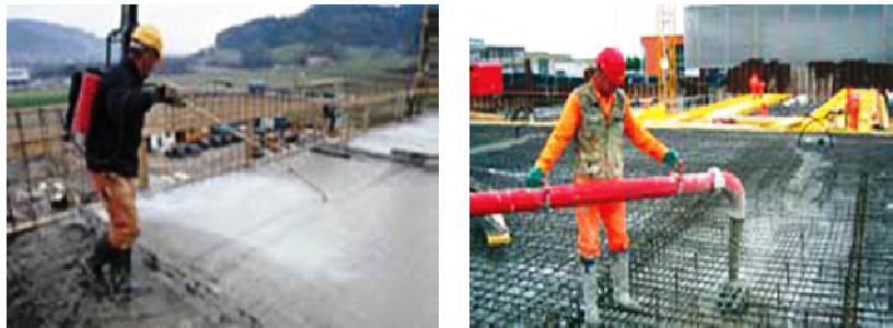
Εικόνα 1.1 (Α) Συμβατικό σκυρόδεμα (απαιτήση δονητικής συμπίκνωσης), (Β) Αυτοσυμπυκνούμενο σκυρόδεμα (πλήρωση καλουπιών χωρίς δόνηση).
