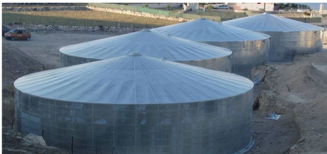
Εικόνα 37: Δεξαμενές αποθήκευσης παραγόμενου νερού μονάδας αντίστροφης ώσμωσης στην Μήλο (ITAGroup, 2021)
