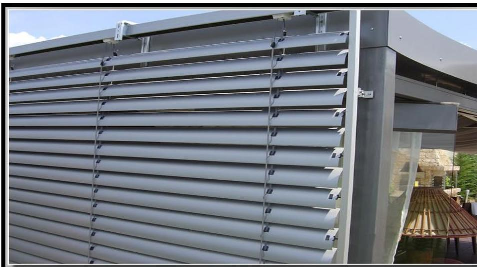
Εικόνα 6.9 : Εξωτερικές μεταλλικές, ρυθμιζόμενες περσίδες [58]
