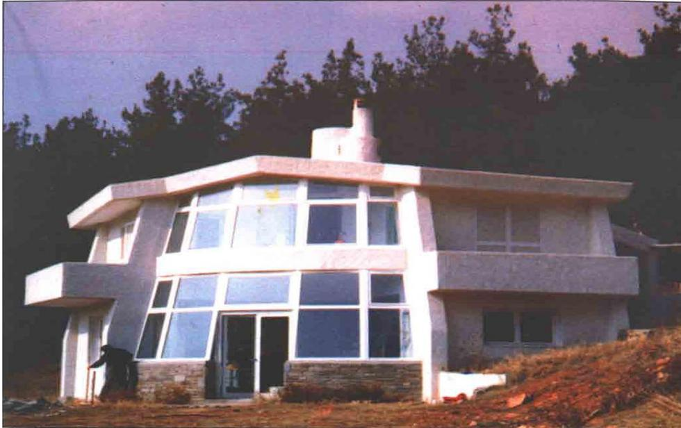
Εικόνα 5.23: Θερμοκήπιο ενσωματωμένο στους χώρους του κτιρίου (κατοικία στο Πανόραμα Θεσσαλονίκης) [21]
