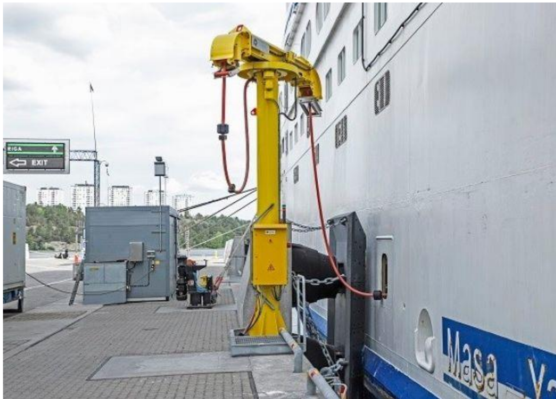
Εικόνα 2.1: Η ακτοπλοϊκή εγκατάσταση cold ironing στην Στοκχόλμη (πηγή Tallink Grupp)
