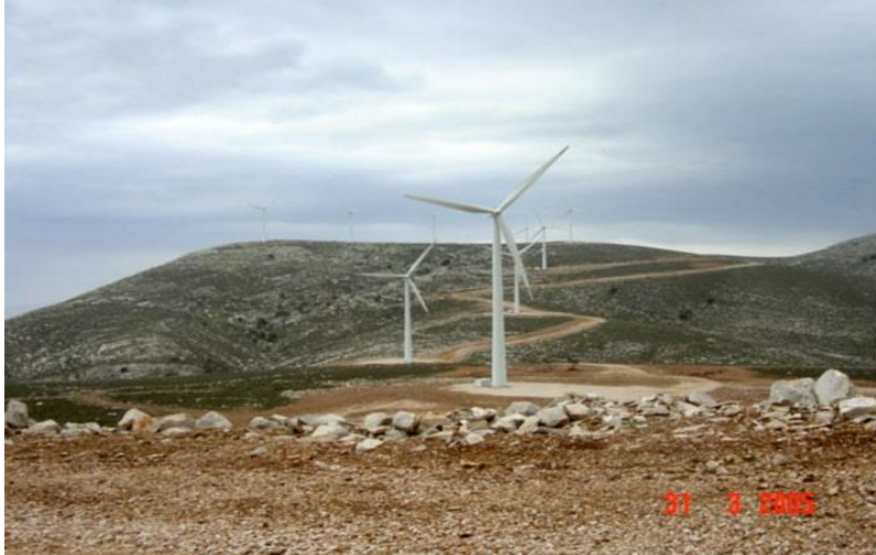
Εικόνα 14: Το αιολικό πάρκο στον Έμπωνα Ρόδου, συνολικής ισχύος 11.7 MW (Πηγή: AENAOS SYSTEMS)
