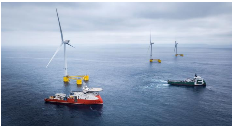
Εικόνα 9: Το πλωτό αιολικό πάρκο WindFloat Atlantic (8.4MW) στην Πορτογαλία. Το καλώδιο προς τον σταθμό ενέργειας στη Viana do Castelo έχει μήκος 20 km (Πηγή: ABS)
