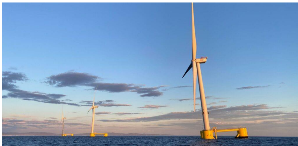
Εικόνα 1: Οι 3 πλωτές Α/Γ MHI Vestas 8.4 MW στο αιολικό πάρκο 20 km από την ακτή του Viana do Castelo στην Πορτογαλία (Πηγή: EDP Renewables)
