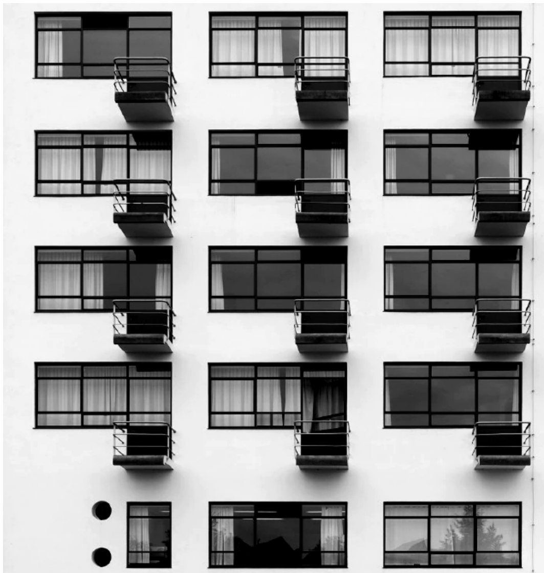
5. Τμήμα όψης κτιρίου Bauhaus στο Dessau με το χαρακτηριστικό μπαλκόνι.
