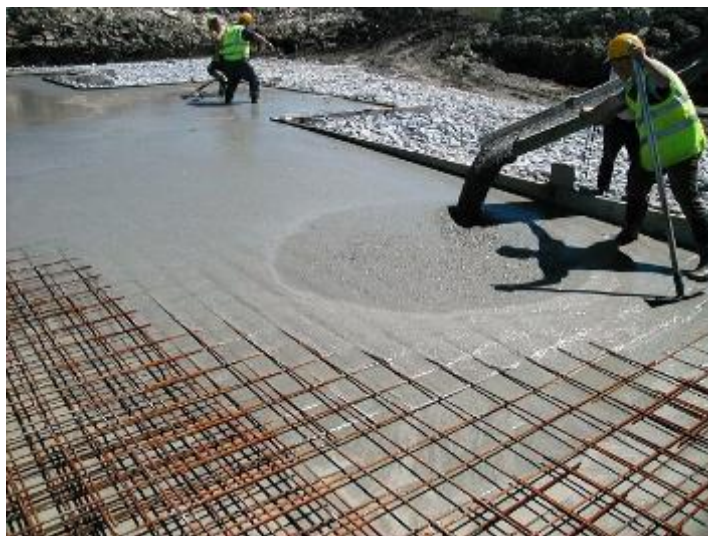
Εικόνα 1.1 Τοποθέτηση ΑΣΣ με αντλία, επιδεικνύοντας τη ρευστότητα του υλικού
