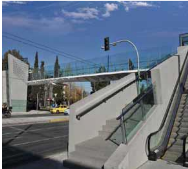
Εικόνα 1.2 Πεζογέφυρα στη Λεωφ. Κηφισίας από ΑΣΣ (Αρχιτεκτονική Μελέτη: Αλ. Σαμαράς κ Συν., Στατική Μελέτη: Φ. Καρυδάκης).
