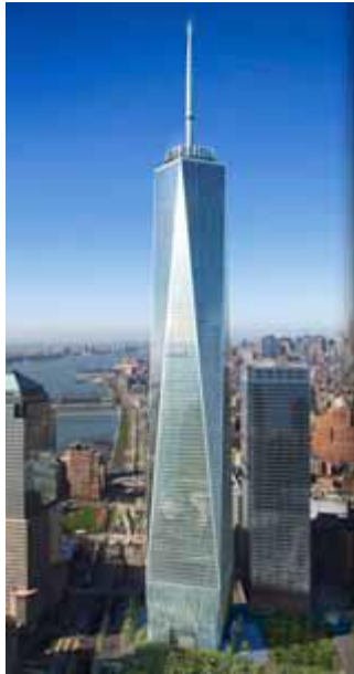
Εικόνα 1.3 Κτίριο One World Trade Center, Νέα Υόρκη
