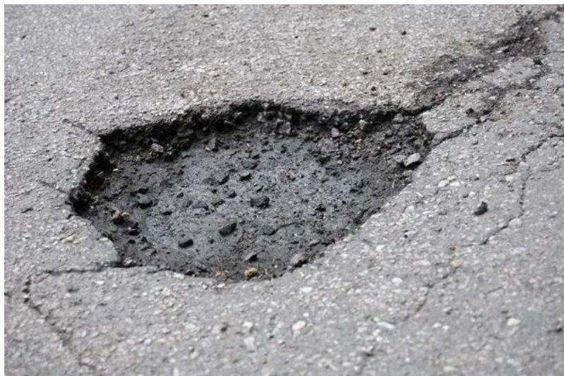
Εικόνα 21 : Λακούβα (Pothole)
