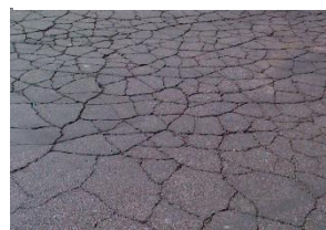
Εικόνα 18 : Μέσο επίπεδο φθοράς σε ρηγμάτωσεις τύπου αλιγάτορα
