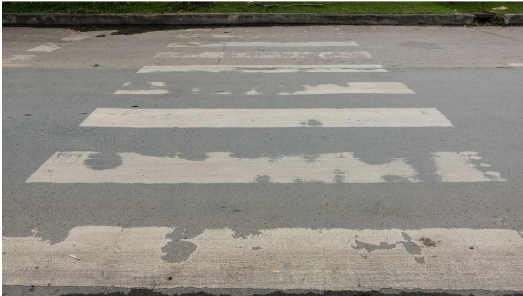
Εικόνα 22 : Παράδειγμα φθοράς οριζόντιας σήμανσης
