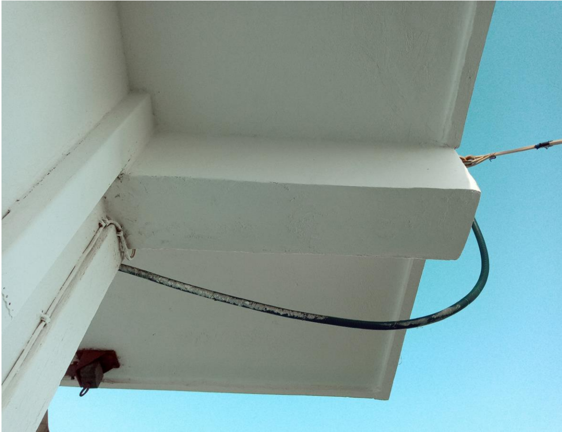
Σχήμα 3.3: Δοκός μετά την επισκευή του οξειδωμένου χάλυβα και του διογκωμένου σκυροδέματος.
