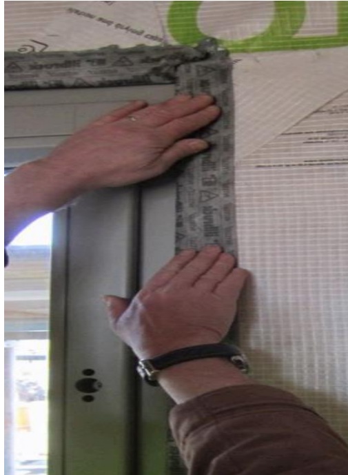
Εικόνα 14: Επικόλληση της σύνδεσης του παραθύρου με τη μεμβράνη αεροστεγανότητας [13]
