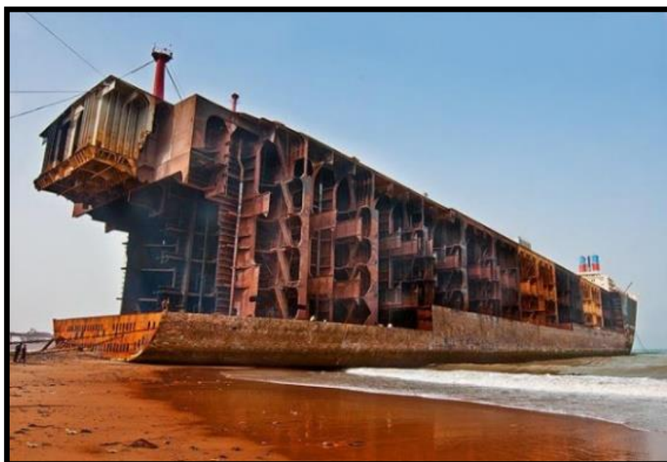
Εικόνα 6: Μέθοδος Beaching (Πηγή: recyclingships.blogspot.com )
