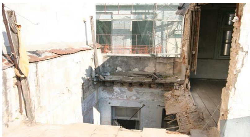
Εικόνα 2.12: Ίχνη από ξύλινα δοκάρια οροφής α' ορόφου
