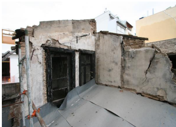
Εικόνα 2.9: Πλαινή όψη 1 ου χώρου δώματος
