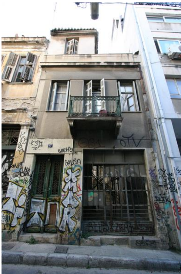
Εικόνα 2.1: Σημερινή πρόσοψη υπό μελέτη κτιρίου
