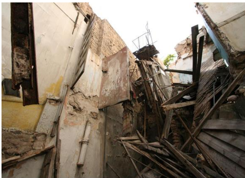
Εικόνα 2.10: Πρόχειρες κατασκευές στον ακάλυπτο
