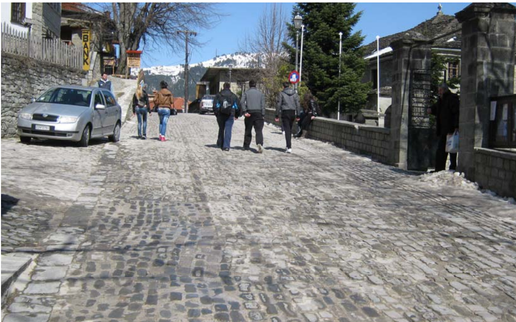
Εικόνα 5: Επίστρωση με κυβόλιθους
