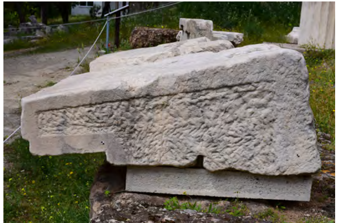
3, 4) Ταινίες επαφής στους αρμούς ώσεως πλευρικών γείσων, όπου είναι ευδιάκριτη η λείανσή τους στα σημεία που αντιστοιχούν σε ορατούς αρμούς, σε αντίθεση αφανείς ζώνες που φέρουν ίχνη οδοντωτού εργαλείου.
