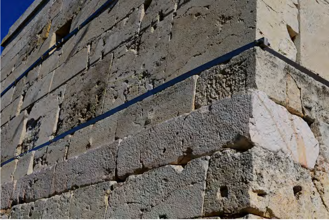
1) Λίθοι από την ευθυνηρία του χορηγικού μνημείου συνθέτουν την πρώτη στρώση τοιχοβάτη στη δυτική όψη του βόρειου πύργου.
