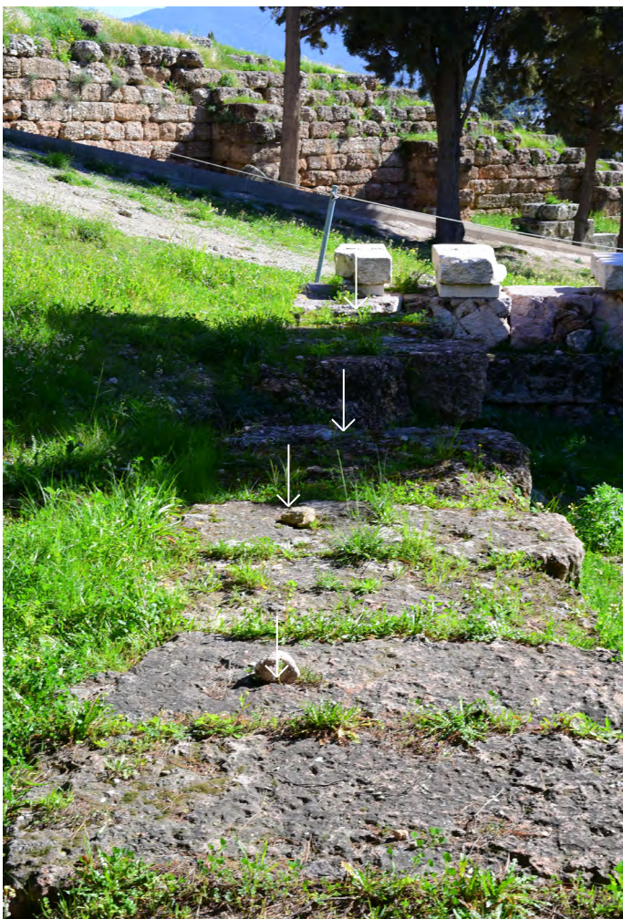
1) Επικοπή στην άνω επιφάνεια του in situ γωνιακού ασβεστόλιθου της ευθυνητήριας για την υποδοχή του υπερκείμενου πώρινου μέλους της πρώτης στρώσης τοιχοβάτη και μοχλοβόθριο για την τοποθέτησή του.
