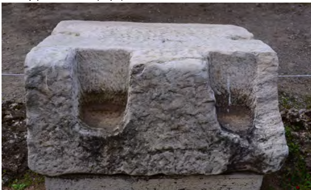
5) Αρμός ώσεως με απόληξη σε πρόμοχθο και με εντορμία κάτω γόμφου.
