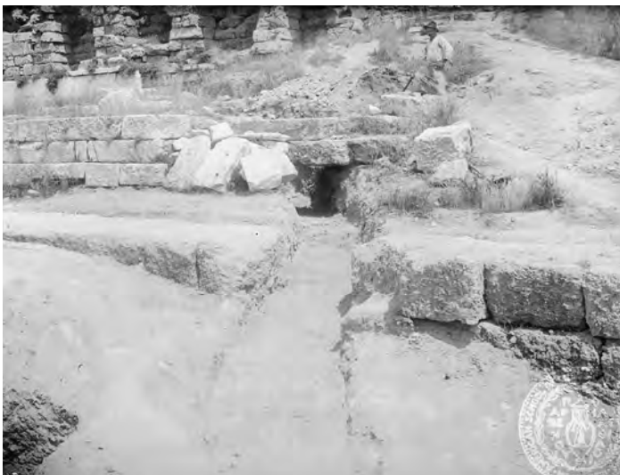
4, 5) Αγωγός ύστερων χρόνων, ο οποίος διασχίζει τον βόρειο θεμελιότοιχο του χορηγικού μνημείου και διέρχεται κάτω από τον αναλημματικό τοίχο στα βόρεια. (ASCSA Digital Archives, αρ. AP 0062, AP 0064, https://ascsa.net/ ).
