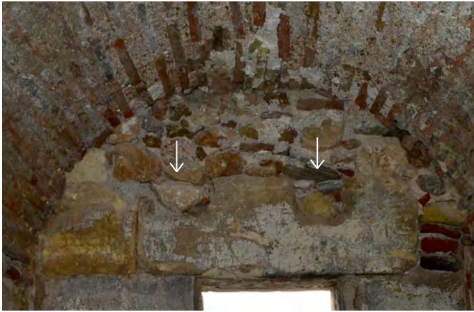
1) Ζεύγος δοκοθηκών στον Βδ5.4, κλεισμένων με λιθοδομή και κονίαμα.
