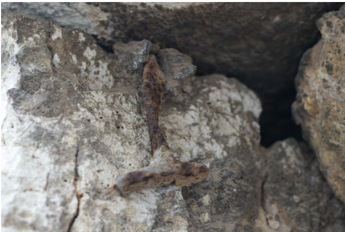
3) Σιδερένιος σύνδεσμος μορφής διπλού T μαζί με το μολύβι του στον ανατολικό αρμό ώσεως του Nβ2.2.
