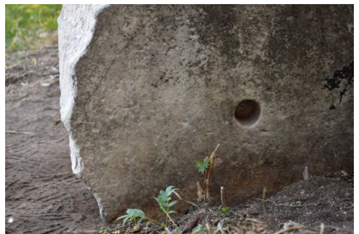
8) Λεπτομέρεια της κάτω έδρας του σπονδύλου στη Βόρεια Κλιτύ: Κυκλική εντορμία για εμπόλιο και διευρυμένη, λεία ταινία επαφής στην περίμετρο.
