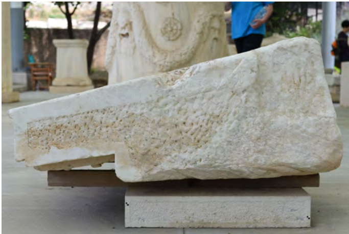
3, 4) Ταινίες επαφής στους αρμούς ώσεως πλευρικών γείσων, όπου είναι ευδιάκριτη η λείανσή τους στα σημεία που αντιστοιχούν σε ορατούς αρμούς, σε αντίθεση αφανείς ζώνες που φέρουν ίχνη οδοντωτού εργαλείου.
