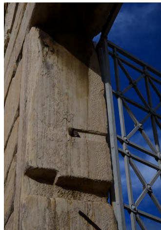
3) Αντίθημα επιστυλίου από τη νότια πλευρά της πρόστασης του μνημείου, εντοιχισμένο στη βορειοανατολική γωνία της μεγάλης αντηρίδας του βόρειου πύργου.
