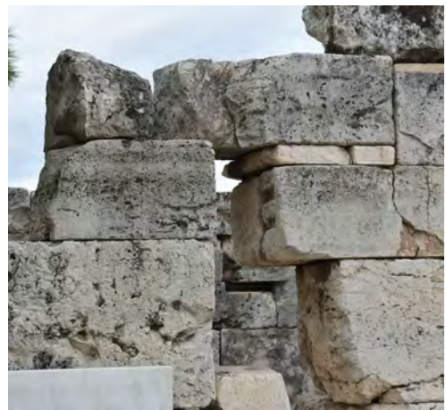
5, 6) Δύο θραύσματα από μετόπες του χορηγικού μνημείου ενσωματωμένα στον ανατολικό τοίχο του νότιου πύργου, με τρόπο που να αποσβένουν την ανισοσταθμία μεταξύ των κάτω στρώσεων πωρόλιθων.
