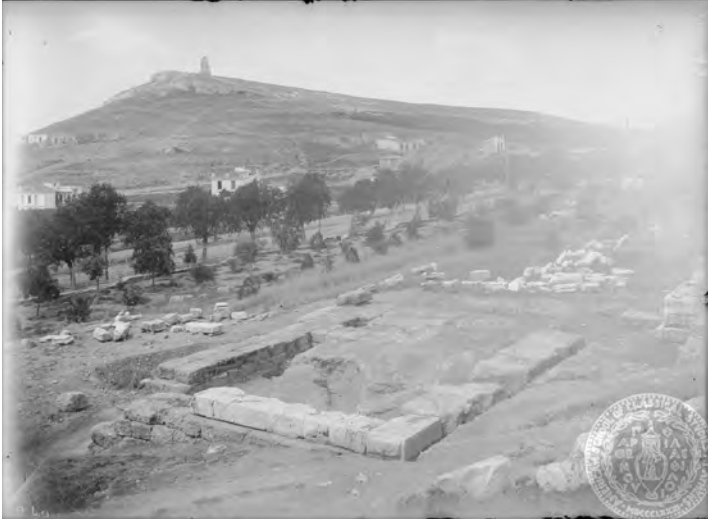
1) Ανασκαφή του θεμελίου του χορηγικού μνημείου από τον Dinsmoor το 1910. Άποψη από τα βορειοανατολικά, (ASCSA Digital Archives, αρ. AP 0060, https://ascsa.net/ ).
