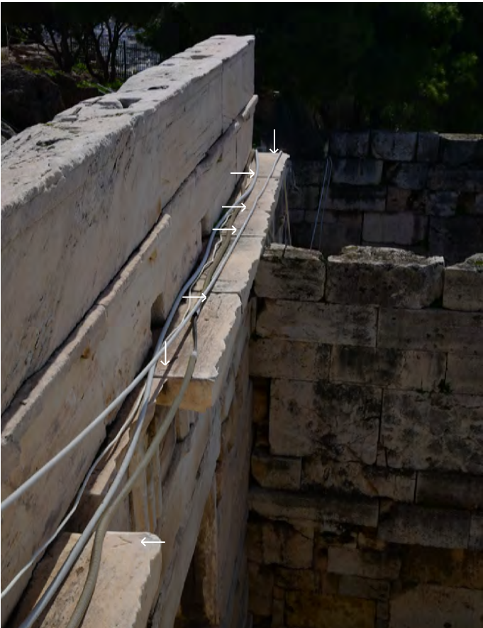
2) Οριζόντια γείσα από το δυτικό αέτωμα, ενσωματωμένα στον δωρικό θριγκό της υστερορρωμαϊκής πύλης. Στην άνω έδρα τους διακρίνονται τα γράμματα της αλφαβητικής ακολουθίας «Α» έως «Η».
