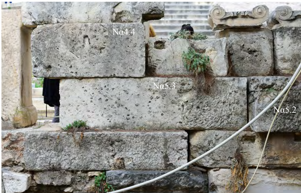
2) Λίθοι από τον βόρειο τοίχο παραστάδος του προνάου ενσωματωμένοι στον ανατολικό τοίχο του νότιου πύργου: Na5.3 του επίμηκους τύπου, Na4.4 (εσωτερικό πρόσωπο λίθου από τη στέψη των ορθοστατών) και Na5.2 (προβάλλει με αρμό ώσεως στην όψη) του βραχέως τύπου.
