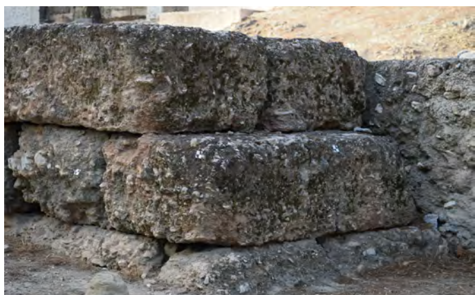
5, 6) Κατά πλάτος διάρθρωση των θεμελίων με τον τρόπο δομής «φορμηδόν και παρά μήκος».
