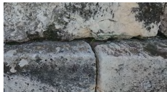
4, 5, 6, 7) Ανοιγμένος αρμός μεταξύ των Na1.4 και Na1.5: Ο λίθος στα αριστερά σώζει άθικτη την ταινία επαφής στον αρμό ώσεως, ενώ η απέναντι παρειά του λίθου στα δεξιά φαίνεται να έχει απολαξευτεί φέροντας χτυπήματα από βελόνι.
