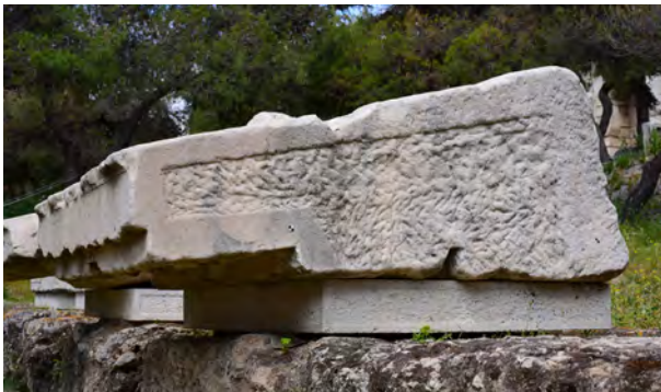
5) Αρμός ώσεως με απόληξη σε πρόμοχθο και με εντορμία κάτω γόμφου.
