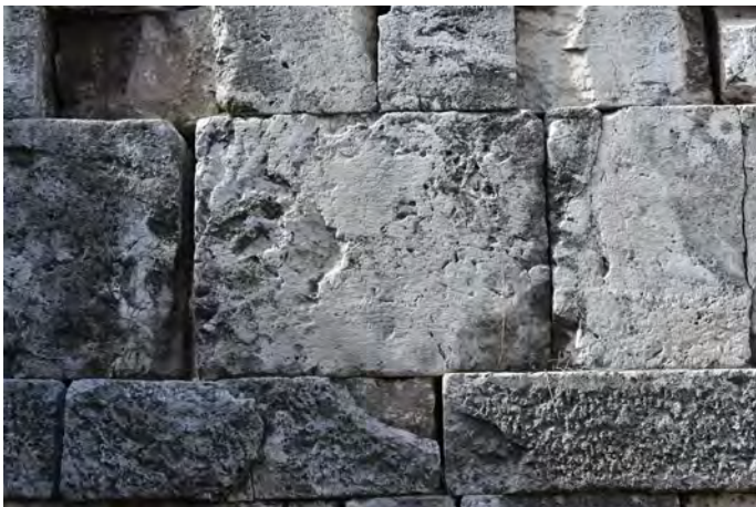
5) Εσωτερικά μέτωπα ορθοστατών και των στέψεών τους κατεργασμένα με οδοντωτό εργαλείο. Η από κάτω στρώση του τοιχοβάτη φέρει ίχνη αδρότερης κατεργασίας με χονδρό βελόνι ή λατομικό τύκο.
