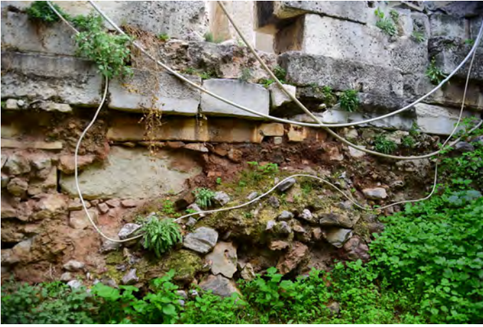
1) Νότιος πύργος, θεμελίωση του ανατολικού τοίχου σε ισχυρό λιθόδεμα. Στα δεξιά κάτω διακρίνεται ο σχιστόλιθος του φυσικού εδάφους.
