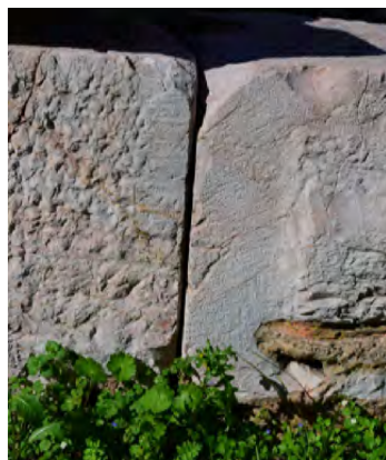
4, 5) Χαρακτηριστικές περιπτώσεις κατεργασίας των μετώπων στους ασβεστόλιθους της ευθυνηρίας: Περιμετρική ταινία με οδοντωτό εργαλείο κατά μήκος των ακμών και χτυπήματα με χονδρό βελόνι στην υπόλοιπη επιφάνεια.
