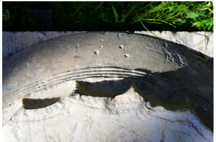
3) Κιονόκρανο NK4944, στην κάτω έδρα του διακρίνεται η ανακουφιστική ταινία, η οποία παρακολουθεί το τόξο κάθε ράβδωσης.
