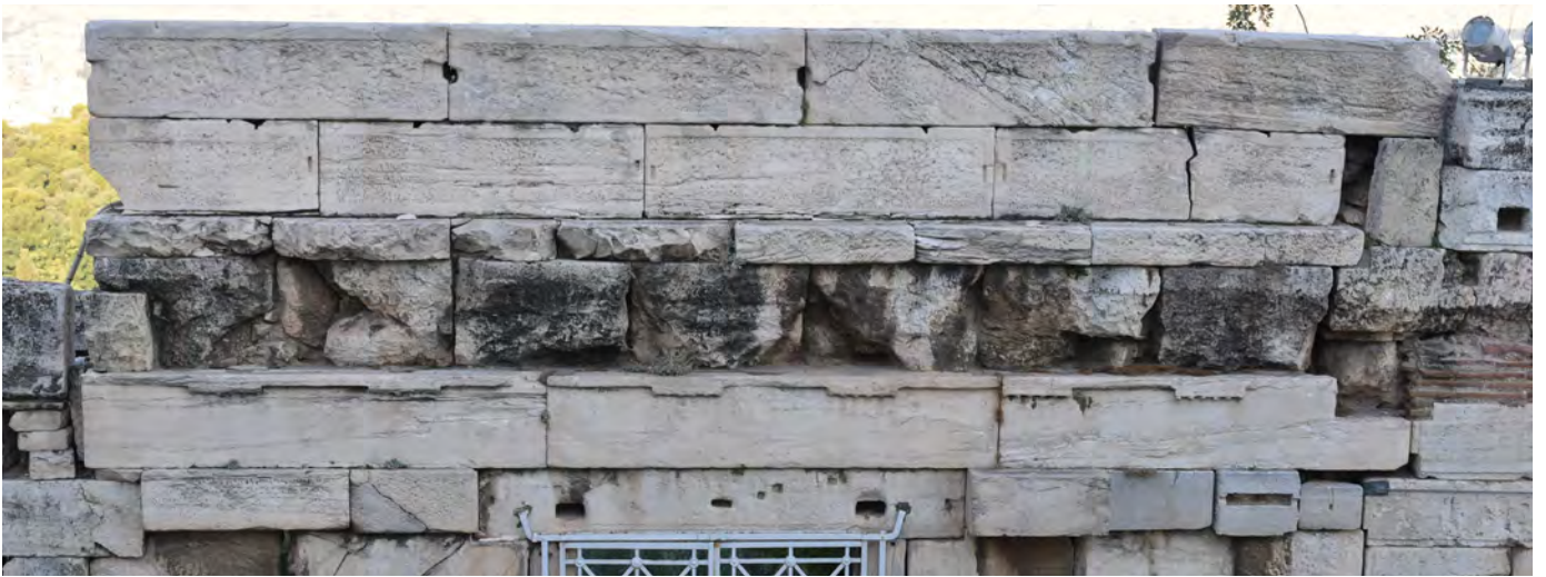
2) Ανατολική όψη των ανώτερων στρώσεων της υστερορρωμαϊκής πύλης. Διακρίνεται στην πίσω παρειά των μαρμάρινων επιστυλίων και των αντιθημάτων τους η περιμετρική ταινία επαφής και τα κάθετα μοχλοβόθρια τοποθέτησής τους.
