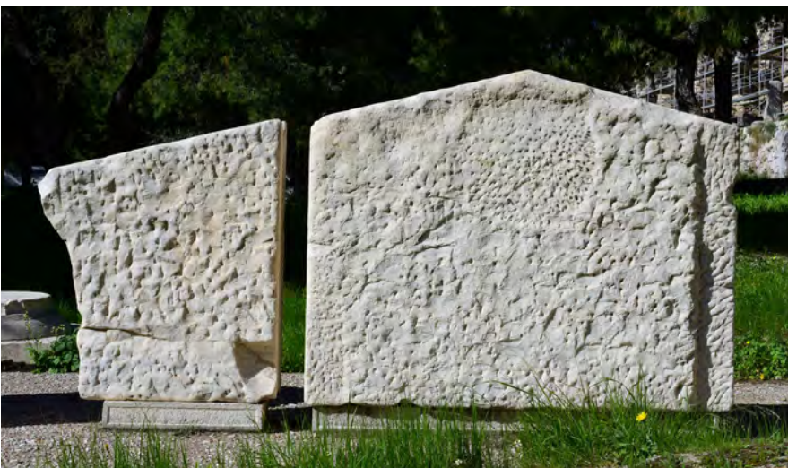
2) Οριζόντια γείσα από το δυτικό αέτωμα, ενσωματωμένα στον δωρικό θριγκό της υστερορρωμαϊκής πύλης. Στην άνω έδρα τους διακρίνονται τα γράμματα της αλφαβητικής ακολουθίας «Α» έως «Η».
