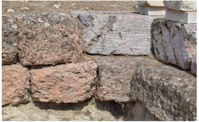
2) Εσωτερική όψη της βορειοανατολικής γωνίας του θεμελίου, όπου παύει να υφίσταται η in situ στρώση ασβεστόλιθων κατά μήκος της βόρειας όψης λόγω ανύψωσης του εδάφους.
