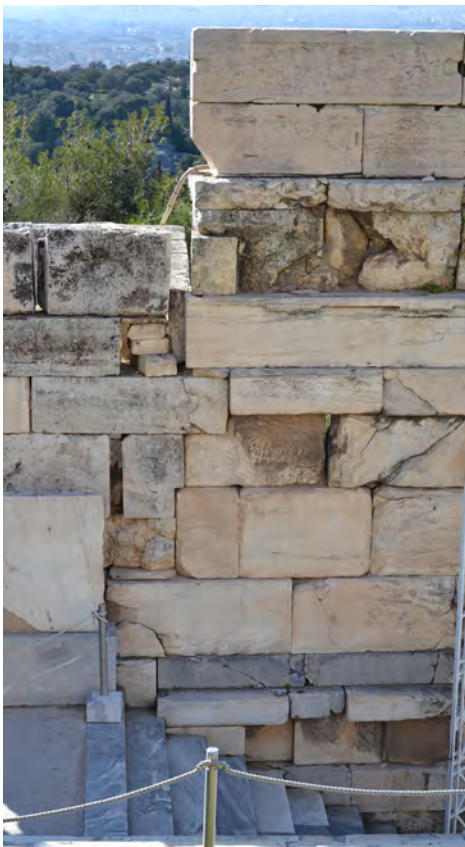
3) Η μετάβαση από τις μαρμάρινες στρώσεις του θυραίου τοίχου στις πώρινες του ανατολικού τοίχου στον νότιο πύργο.
