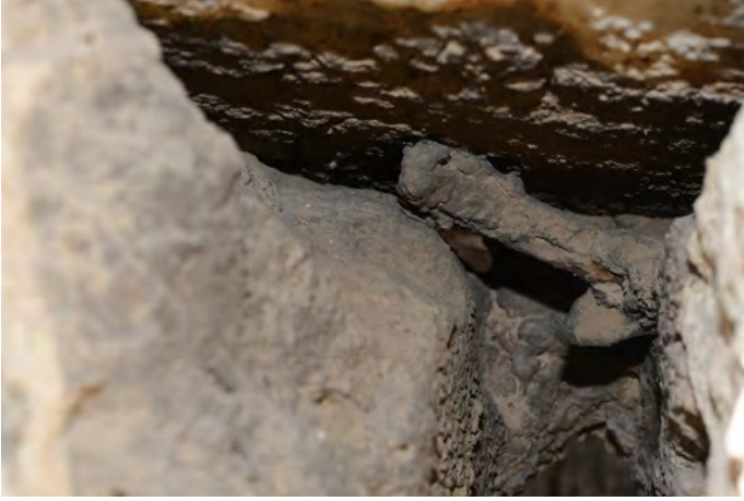
1) Αθικτος σιδερένιος σύνδεσμος μορφής διπλού T μαζί με το μολύβι του μεταξύ των λίθων Nδ5.6 και Nν5.6. Ο αρμός έχει ανοίξει σε τέτοιο βαθμό λόγω καθίζησης του πύργου, που ο σύνδεσμος έχει ξεκολλήσει από τον Nδ5.6, σπάζοντας την εντορμία.
