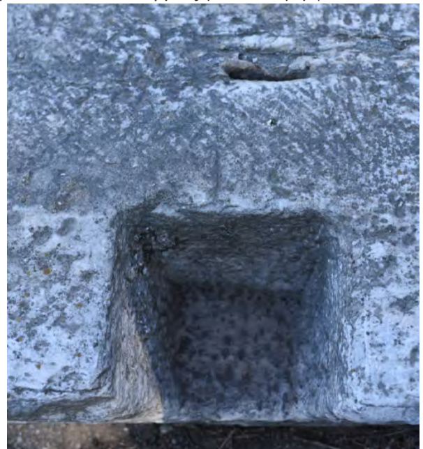
9) Χαραγή (σημεία) στην άνω έδρα του πλευρικού γείσου στην «Ιουστινιάνεια» δεξαμενή, η οποία εντοπίζεται με μικρή εκκεντρότητα ως προς τον άξονα της δοκοθήκης.
