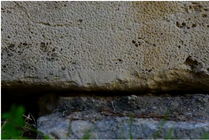
3) Ορατή εσωτερική επιφάνεια λιθόπλινθου από τον πρόναο με πυκνή διάστικτη κατεργασία, η οποία οριοθετείται χαμηλά κατά μήκος της κάτω οριζόντιας ακμής του λίθου με λεία ταινία.
