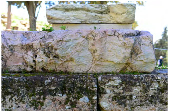
3) Η αφανής πίσω παρειά ενός από τους in situ σωζόμενους ασβεστόλιθους της ευθυνηρίας, όπου στο κάτω μέρος διακρίνονται κατάλοιπα από την αύλακα λατόμησης και από τις υποδοχές για σφήνες.
