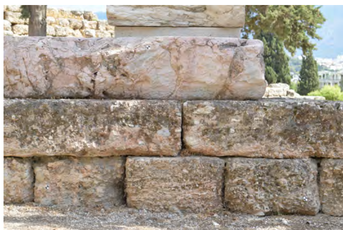
3) Σύστημα δόμησης «φορμηδόν και παρά μήκος» στην εσωτερική όψη του ανατολικού θεμελιότοιχου.
