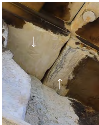
3) Το ίδιο σύστημα σήμανσης με αλφαβητική ακολουθία εφαρμόστηκε επίσης στην κάτω έδρα των γείσων, όπως μαρτυρείται από θέσεις που έχουν χαθεί οι μετόπες. Αριστερά ένα ζεύγος από «Ζ» και δεξιά ένα «Η».
