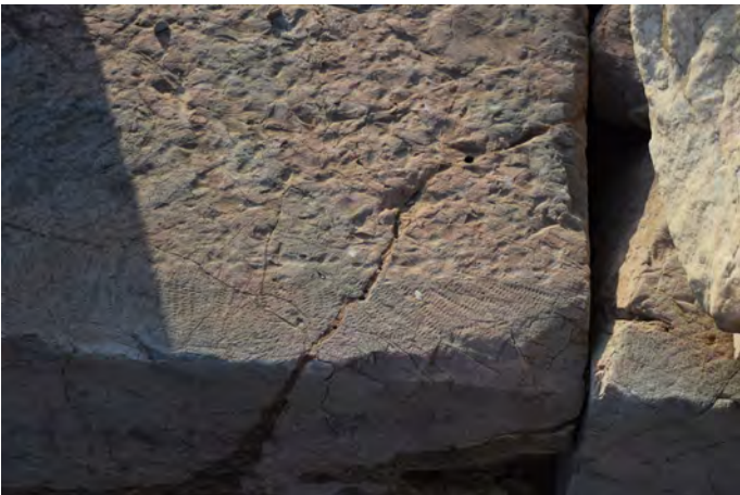
2) Επιμελώς κατεργασμένη ταινία στην άνω παρειά των in situ σωζόμενων ασβεστόλιθων της ευθυνηρίας, από την οποία προκύπτει η εσοχή της υπερκείμενης πρώτης στρώσης τοιχοβάτη του σηκού.
