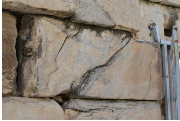
2) Εσωτερική παρειά του Θ7.4, στην οποία διακρίνονται δεξιά και αριστερά τα κατάλοιπα των κυματίων της βάσης και της στέγης που απολαξεύτηκαν κατά την αναχρησιμοποίηση του μαρμάρου στην πύλη.
