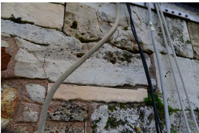
6) Ο πιθανολογούμενος ως λίθος επιτοίχιου αντιθήματος επιστυλίου Ββ8.2α, στην άνω έδρα του οποίου διακρίνεται το γράμμα «Ζ». Από κάτω του προβάλλει με τον αρμό ώσεώς της η μαρμάρινη μετόπη Ββ8.2β.
