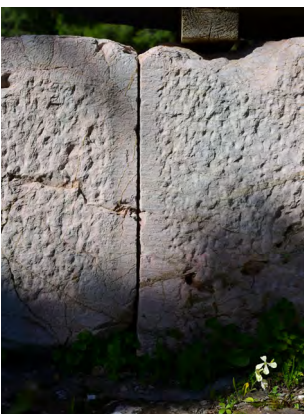
4, 5) Χαρακτηριστικές περιπτώσεις κατεργασίας των μετώπων στους ασβεστόλιθους της ευθυνηρίας: Περιμετρική ταινία με οδοντωτό εργαλείο κατά μήκος των ακμών και χτυπήματα με χονδρό βελόνι στην υπόλοιπη επιφάνεια.
