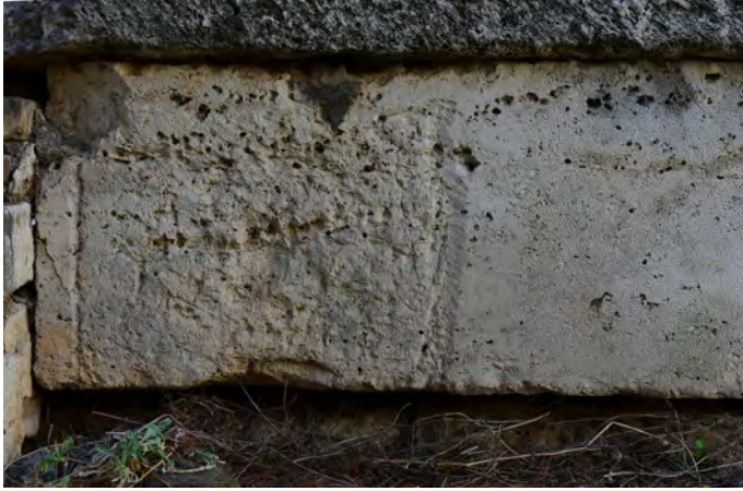
1) Επιμήκης λίθος παραστάδος Nδ6.4, αναθύρωση για την εγκάρσια σύνδεση με λίθο του θυραίου τοίχου.
