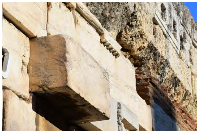
5) Το μάρμαρο Θ6.3, φέρει αναθηματική επιγραφή στη νότια πλευρά του και είναι τοποθετημένο ανάποδα στον θυραίο τοίχο.
