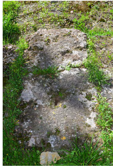
4) Χαρακτηριστική περίπτωση μοχλοβοθρίου σε έναν από τους κροκαλοπαγείς λίθους στον βόρειο θεμελιότοιχο.
