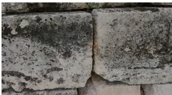
4, 5, 6, 7) Ανοιγμένος αρμός μεταξύ των Na1.4 και Na1.5: Ο λίθος στα αριστερά σώζει άθικτη την ταινία επαφής στον αρμό ώσεως, ενώ η απέναντι παρειά του λίθου στα δεξιά φαίνεται να έχει απολαξευτεί φέροντας χτυπήματα από βελόνι.
