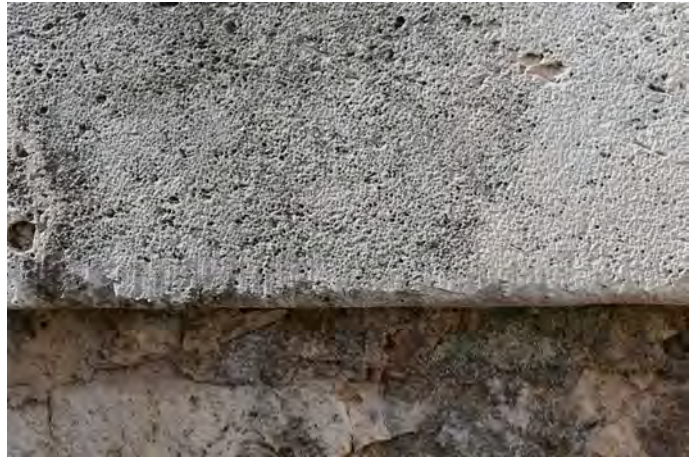
2) Ορατή εξωτερική επιφάνεια λιθόπλινθου με πυκνή διάστικτη κατεργασία. Κατά μήκος της κάτω οριζόντιας ακμής του λίθου λεία ταινία, όπου διακρίνονται τα ίχνη διαμόρφωσής της με λαμάκι.
