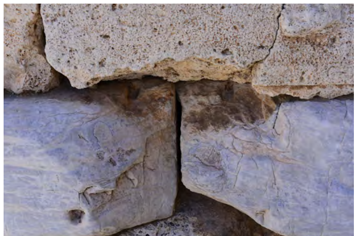
6) Απολαξευμένη εντορμία υποδοχής μεταλλικού συνδέσμου μορφής διπλού T μεταξύ των μαρμάρων Θ15.4, Θ15.5 στην υστερορωμαϊκή πύλη.
