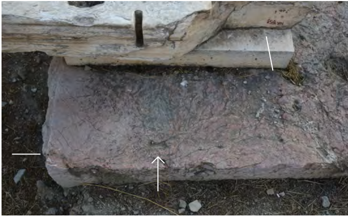
1) Επικοπή στην άνω επιφάνεια του in situ γωνιακού ασβεστόλιθου της ευθυνητήριας για την υποδοχή του υπερκείμενου πώρινου μέλους της πρώτης στρώσης τοιχοβάτη και μοχλοβόθριο για την τοποθέτησή του.
