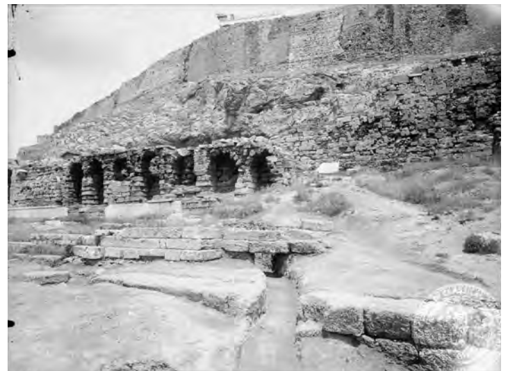
4, 5) Αγωγός ύστερων χρόνων, ο οποίος διασχίζει τον βόρειο θεμελιότοιχο του χορηγικού μνημείου και διέρχεται κάτω από τον αναλημματικό τοίχο στα βόρεια. (ASCSA Digital Archives, αρ. AP 0062, AP 0064, https://ascsa.net/ ).
