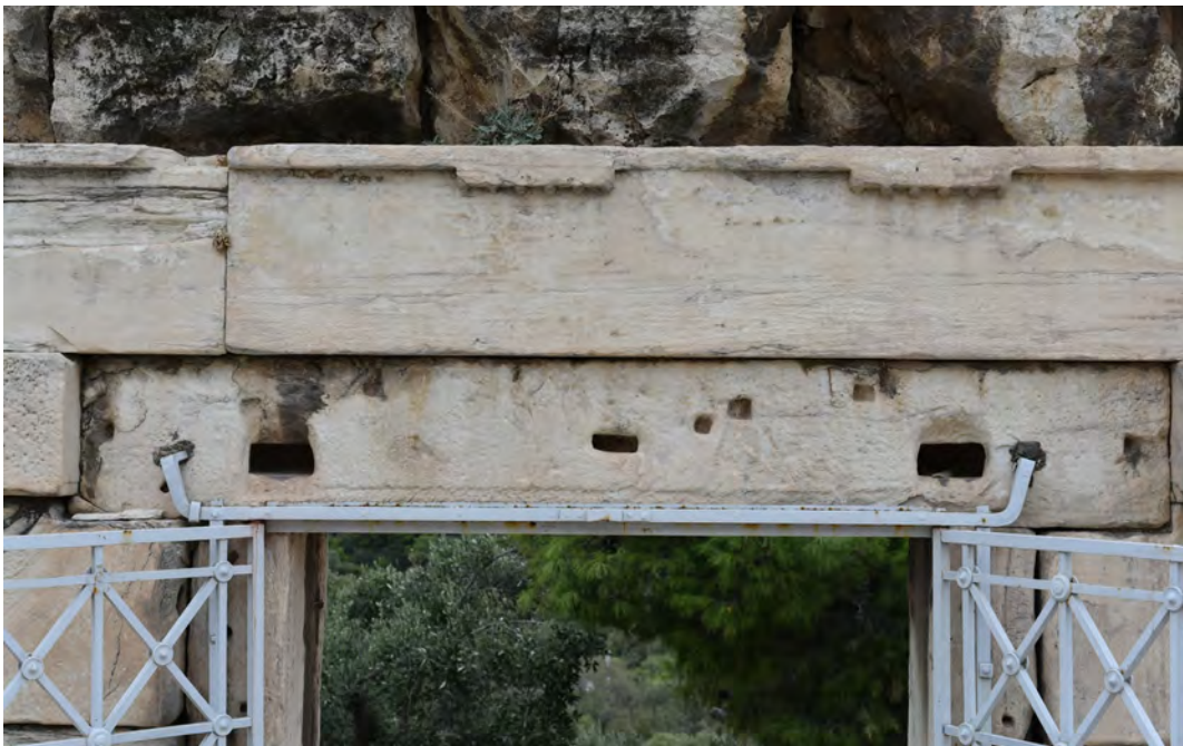
3) Εσωτερική όψη του ανωφλίου της πύλης, αρχικά η άνω έδρα ενός μέλους με διαδοχικές αναχρησιμοποιήσεις, όπως μαρτυρείται από τις διαφορετικές εντορμίες για γόμφους και λύκους ανύψωσης.
