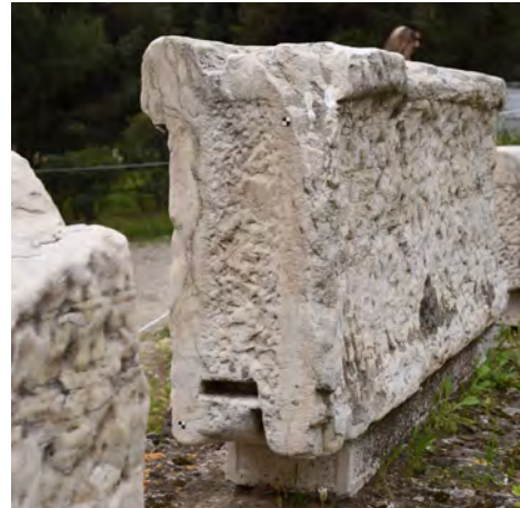
4) Αρμός ώσεως του επιστυλίου: Στην κάτω πλευρά πέρα από την εντορμία για γόμφο υπάρχει ορθογωνικό λάξευμα, το οποίο σχετίζεται πιθανόν με την τοποθέτηση του μέλους στη θέση του.
