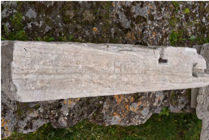
3) Άνω παρειά του επιστυλίου, όπου διακρίνεται το γράμμα «Η» καθώς και μία εντορμία οριζόντιας σύνδεσης με τον λίθο αντιθήματος.
