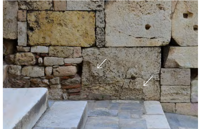
6) Ίχνη τριών βαθμίδων στο πρόσωπο του Νβ9.1 που εντάσσονταν σε κλίμακα, η οποία καταλάμβανε όλο το πλάτος του μεταπύργου διαστήματος και οδηγούσε σε ένα σχετικά στενό πλατύσκαλο μπροστά από την πύλη.
