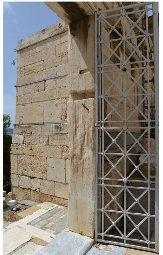
4, 5) Οι παραστάτες της πύλης (Θ10.4, Θ10.5) προέρχονται από την άνω απόληξη του θυραίου τοίχου προς την πλευρά του προνάου και αποτελούν συνέχεια της στρώσης των αντιθημάτων του επιστυλίου. Έφεραν επίσης προεξέχουσα ταινία με δωρικό κυμάτιο, η οποία απολαξεύτηκε με σχετικά μικρό βελόνι κατά την επανάχρησή τους, όπως μαρτυρείται από τα σωζόμενα ίχνη.
