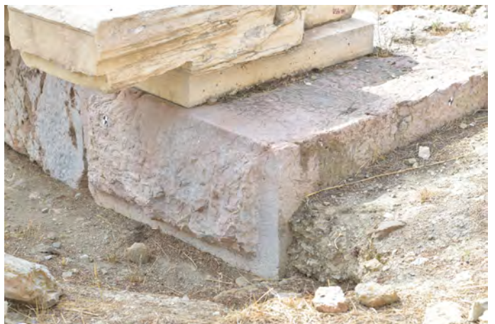
6) Έντονη προεξοχή απέργου στο ανατολικό πρόσωπο του ασβεστόλιθου της βορειοανατολικής γωνίας της ευθυνηρίας.
