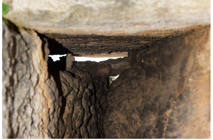
2) Σιδερένιος σύνδεσμος μορφής διπλού T μαζί με το μολύβι του στον ανοιγμένο αρμό μεταξύ των Nδ5.5 Nδ5.6.
