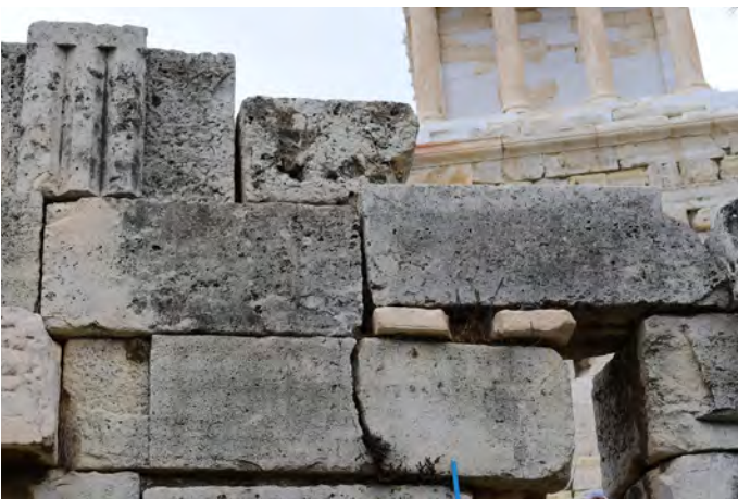
5, 6) Δύο θραύσματα από μετόπες του χορηγικού μνημείου ενσωματωμένα στον ανατολικό τοίχο του νότιου πύργου, με τρόπο που να αποσβένουν την ανισοσταθμία μεταξύ των κάτω στρώσεων πωρόλιθων.
