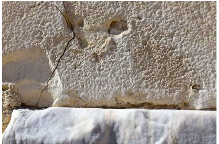
4) Ορατή εξωτερική επιφάνεια λιθόπλινθου με πυκνή διάστικτη κατεργασία και ίχνη της λείας ταινίας κατά μήκος της οριζόντιας κάτω ακμής του λίθου.
