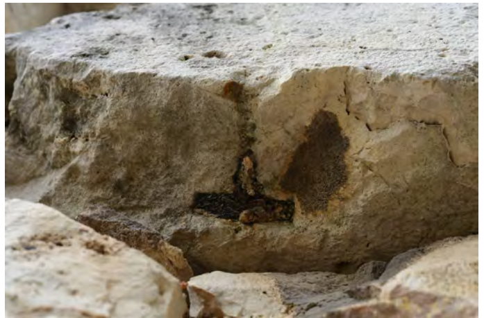
4) Κατάλοιπα σιδερένιου συνδέσμου μέσα σε εντορμία στη σημερινή κάτω παρειά του Nν3.5.
