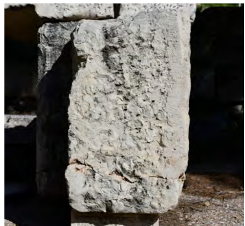
4) Αναθύρωση σε αρμό ώσεως τριγλύφου. Οι ταινίες επαφής διαμορφωμένες επιμελώς με οδοντωτό εργαλείο.
