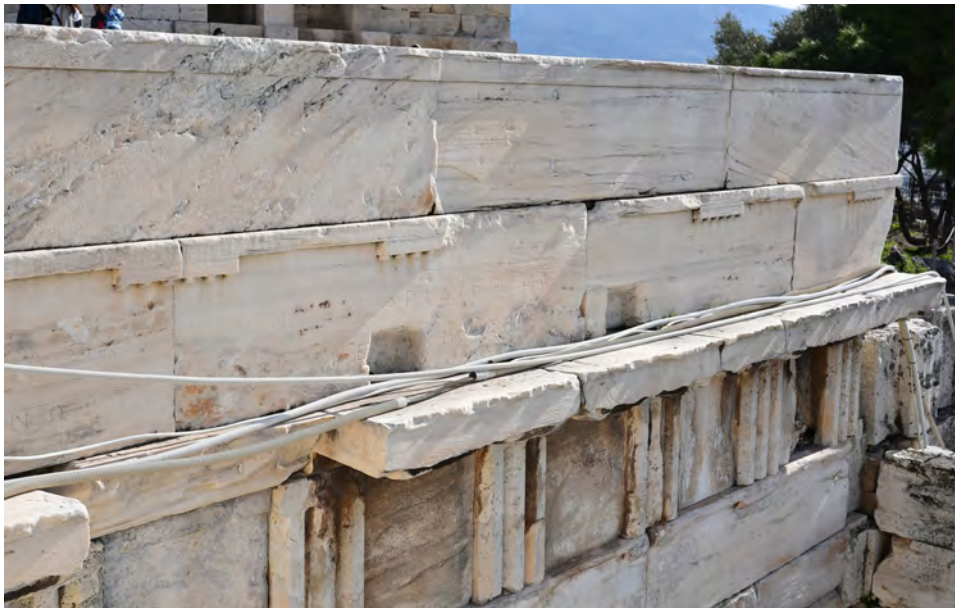
1) Διαμόρφωση της άνω απόληξης της υστερορρωμαϊκής πύλης με επιστύλια της πρόστασης (κάτω) και με τα αντιθήματά τους (πάνω).
