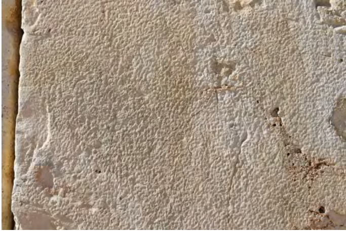
1) Ορατή εξωτερική επιφάνεια λιθόπλινθου με πυκνή διάστικτη κατεργασία.
