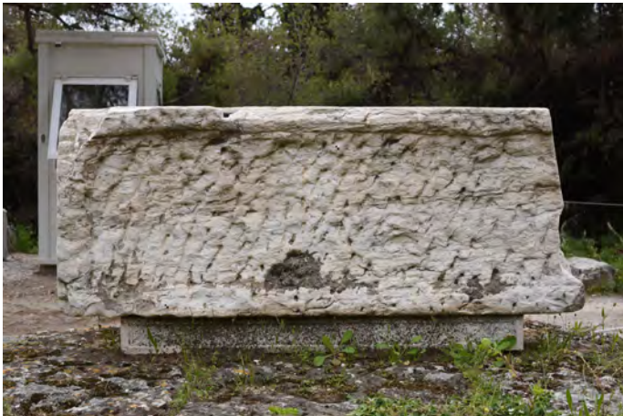
3) Άνω παρειά του επιστυλίου, όπου διακρίνεται το γράμμα «Η» καθώς και μία εντορμία οριζόντιας σύνδεσης με τον λίθο αντιθήματος.
