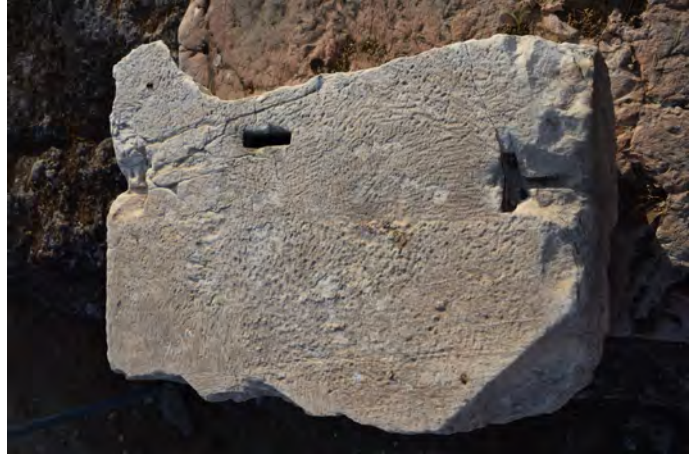
2) Άνω παρειά οριζόντιου γείσου: Η επιφάνεια είναι κατεργασμένη κυρίως με βελόνι και με οδοντωτό εργαλείο σε περιοχές που απαιτούν καλύτερη συναρμογή με τις υπερκείμενες στρώσεις, στην προκειμένη περίπτωση με τον ορθοστάτη του αετώματος.
