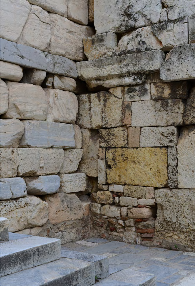
1) Η συμβολή των χαμηλότερων στρώσεων του θυραίου τοίχου με τον βόρειο τοίχο του νότιου πύργου.
