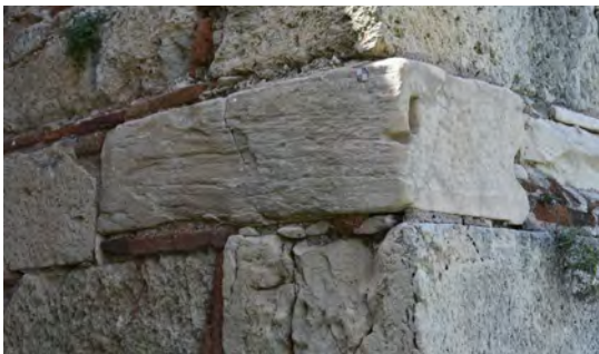
3) Αντίθημα επιστυλίου από τη νότια πλευρά της πρόστασης του μνημείου, εντοιχισμένο στη βορειοανατολική γωνία της μεγάλης αντηρίδας του βόρειου πύργου.
