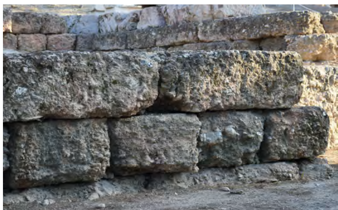
4) Σύστημα δόμησης «φορμηδόν και παρά μήκος» στην εξωτερική όψη του νότιου θεμελιότοιχου.
