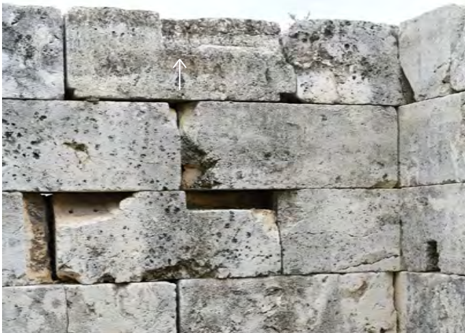
3) Δοκοθήκη ανοιγμένη στο εσωτερικό πρόσωπο του Νδ1.2, ο οποίος βρίσκεται παρατοποθετημένος στη θέση αυτή μετά την αποκατάσταση του νότιου πύργου το 1888.
