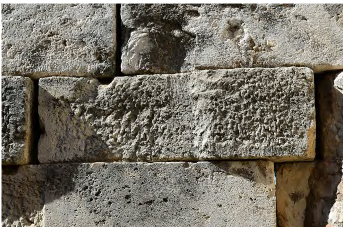
5) Η εσωτερική παρειά του γωνιακού λίθου τοιχοβάτη Nδ5.2 με αναθύρωση και εντορμία για οριζόντιο σύνδεσμο μορφής διπλού T.
