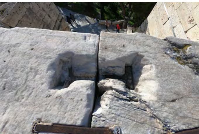
5) Κατάλοιπα σιδήρου μέσα σε εντορμία στο μαρμάρινο μέλος αντιθήματος Θ1.2.
