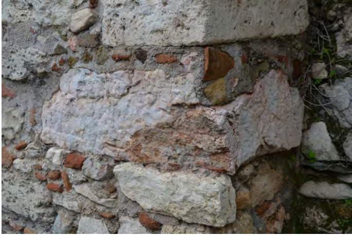
1, 2) Επαναχρησιμοποιημένος ασβεστόλιθος σε αντηρίδα του τείχους της Υπαπαντής, ο οποίος θα μπορούσε να προέρχεται από την ευθυντηρία του μνημείου του Νικίου.
