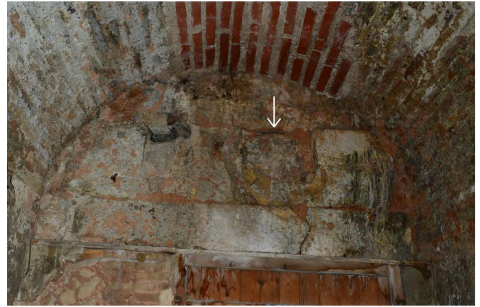
2) Δοκοθήκη ανοιγμένη σε λιθόπλινθο στον ανατολικό τοίχο του βόρειου πύργου.
