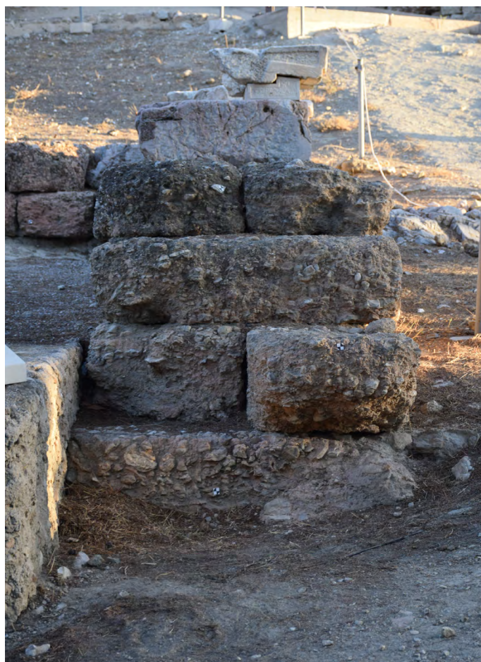
5, 6) Κατά πλάτος διάρθρωση των θεμελίων με τον τρόπο δομής «φορμηδόν και παρά μήκος».
