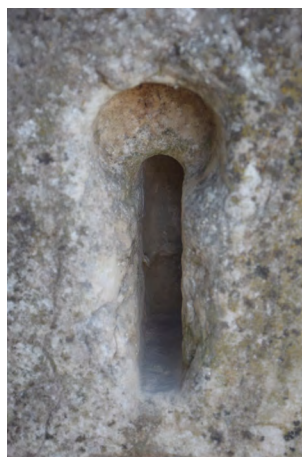
6,7) Λεπτομέρεια της άνω έδρας του σπονδύλου στη Βόρεια Κλιτύ: Η εντορμία για ένθεση λύκου έχει αλληλεπικάλυψη με την κυκλική εντορμία για εμπόλιο.
