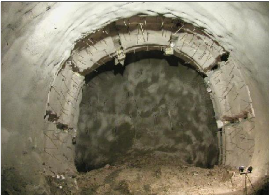
Εικόνα 4.10. Παράδειγμα κατασκευής διατομής ενδοτικού τύπου. (Ιωαννίδου, 2014)
