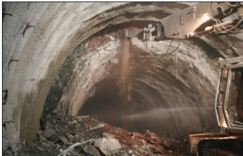
Εικόνα 4.14. Αστοχία προσωρινής υποστήριξης λόγω αυξημένων συγκλίσεων σε σχιστώδη σερπεντινίτη. Αντίληψη: Ιωαννίδου (2014).
