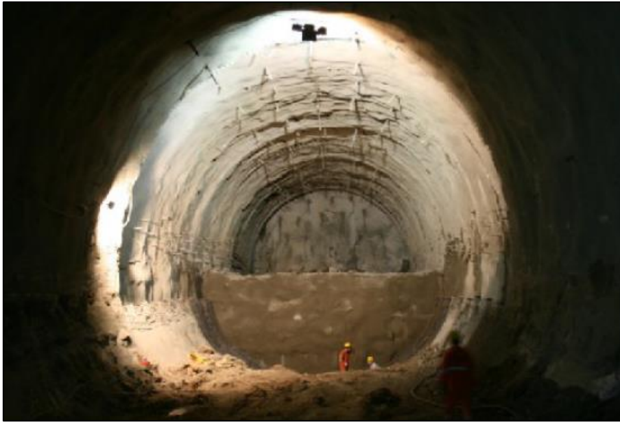
Εικόνα 4.9. Νότιο μέτωπο – Ακαμπτη Υποστήριξη Β' Φάση (Ιωαννίδου, 2014)
