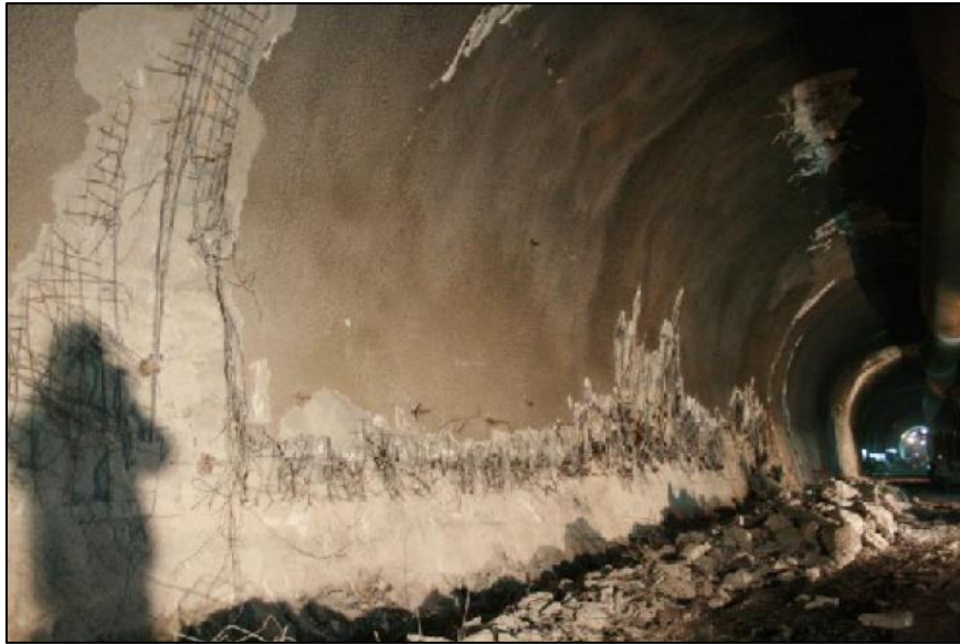
Εικόνα 4.15. Αστοχία σε Σχιστώδη Σερπεντινίτη. Άντληση: (Ιωαννίδου, 2014)
