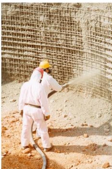
Εικόνα 2.4. Εκτόξευση σκυροδέματος. Άντληση: (Σοφινός, 2018)
