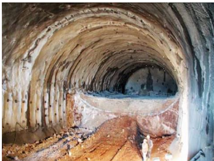
Εικόνα 2.8. Κατασκευή προσωρινού και τελικού ανάστροφου τόξου (Μαρίνος Π. , Σημειώσεις μαθήματος: Σχεδιασμός Υπογείων Έργων, 2005)
