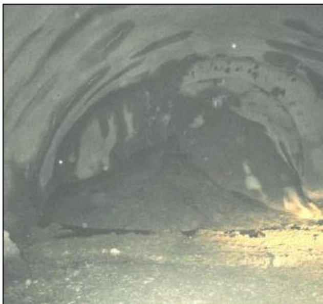
Εικόνα 4.28. Αστοχία μετώπου βόρειας σήραγγας Τεμπών T3 (Μαρίνος Π., 2014).
