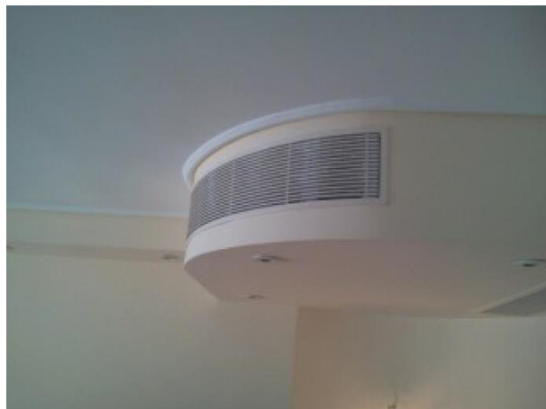
Εικόνα 14: Ειδική κατασκευή καμπύλου στομίου
