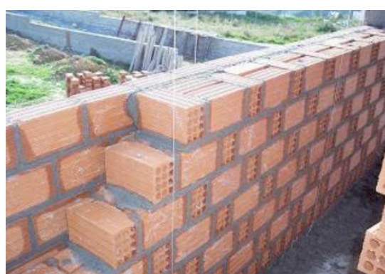
Εικόνα 1.4: Υπερμπατική τοιχοποιία πάχους 29 εκατοστών
