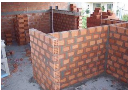
Εικόνα 1.1: Δρομική τοιχοποιία πάχους 9 εκατοστών
