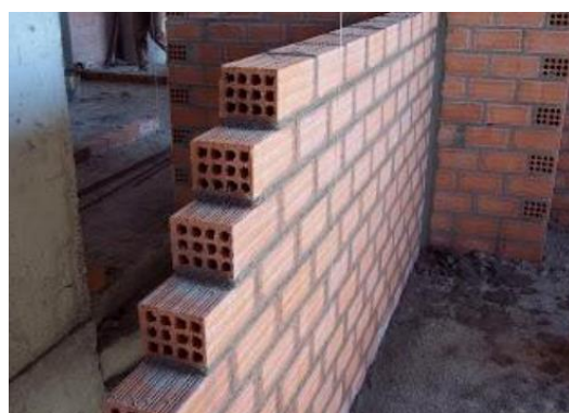
Εικόνα 1.2: Δρομική τοιχοποιία πάχους 12 εκατοστών
