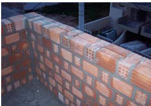
Εικόνα 1.3: Μπατική τοιχοποιία πάχους 19 εκατοστών
