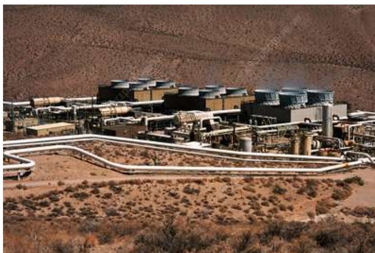
Εικόνα 19: Γεωθερμικό εργοστάσιο στο γεωθερμικό πεδίο του Coso.
