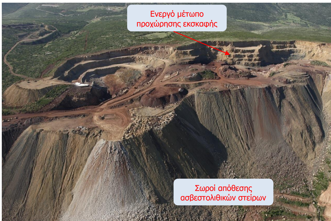
Εικόνα 8. Αεροφωτογραφία εργοταξίου Νησιού
