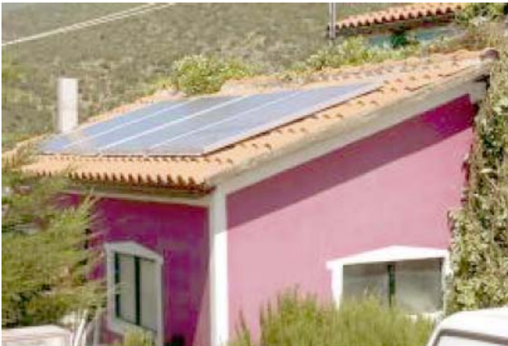
Εφαρμογή φωτοβολταϊκών σε κεραμοσκεπή εξοχικής κατοικίας (Σ.Ε.Φ., ένας πρακτικός οδηγός)
