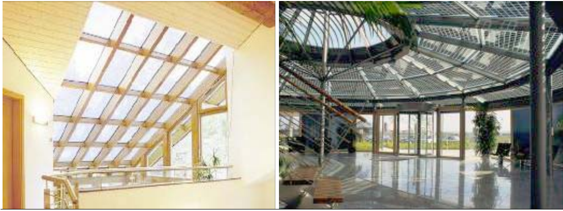
Εφαρμογή φωτοβολταϊκών που επιτρέπουν τη διέλευση του φυσικού φωτός [9]
