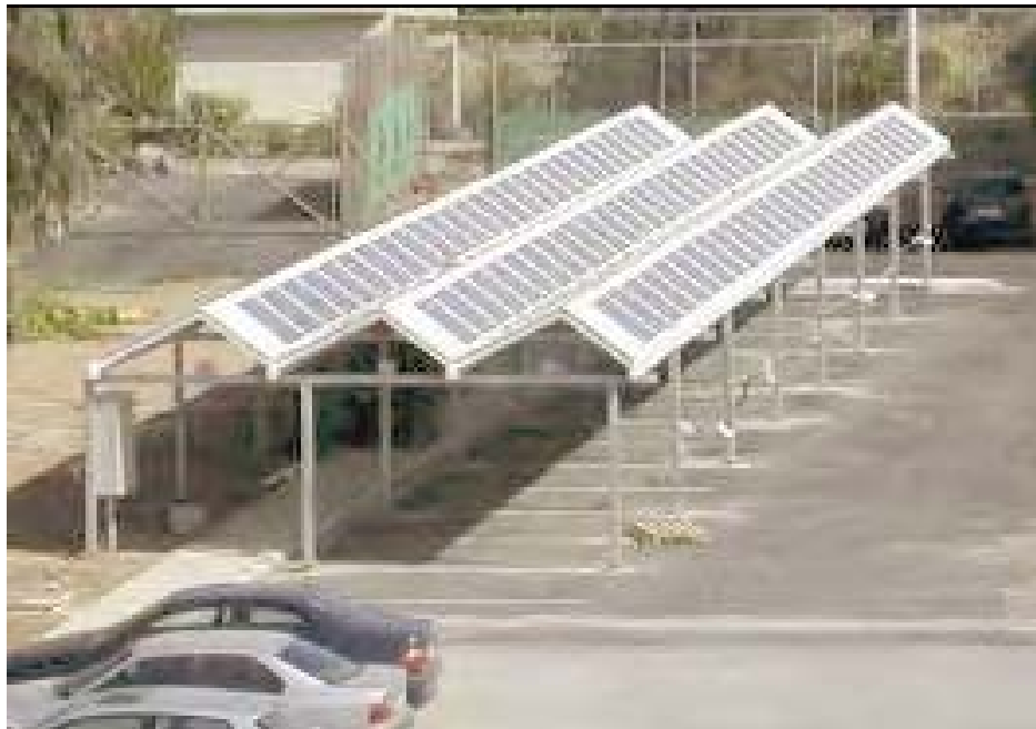
φ/β σε χώρο στάθμευσης στο Μαρούσι
