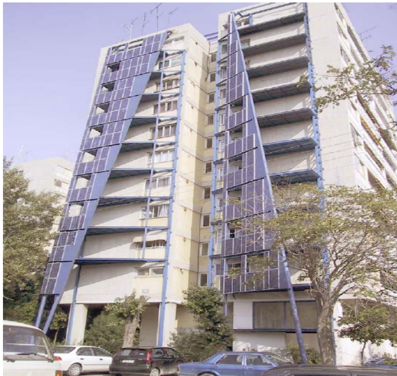
12 KWp σε πολυκατοικία στον Ταύρο
