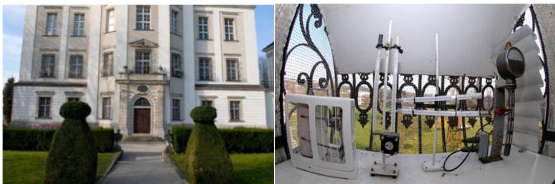
Σχήμα 4.6. Η ιστορική θέση μέτρησης θερμοκρασίας και υγρασίας 6.9m πάνω από το έδαφος στη ΒΒΑ πρόσοψη του ιστορικού αστρονομικού πύργου στο Μοναστήρι Kremsmünster της Αυστρίας (Böhm et al. , 2010). Αριστερά: Οι τρεις πρώτοι όροφοι του οκταόροφου κτιρίου, Δεξιά: Υπερευρυγώνια φωτογραφία τραβηγμένη μέσα στο δωμάτιο μετεωρολογικών μετρήσεων
