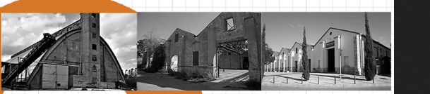
Λεμνός, Περιοχή μεταξύ Νέου και Παλιού Λιμανού, η παλιά αποθήκη Χαρωμίνης σταλίδια της Πλούσιας Βιομηχανικής κουλτούρας της Λεμνού, που όμως σήμερα είναι εγκαταλεημένα και παραδομένα στη φύση και στη φυσική βόλη.
