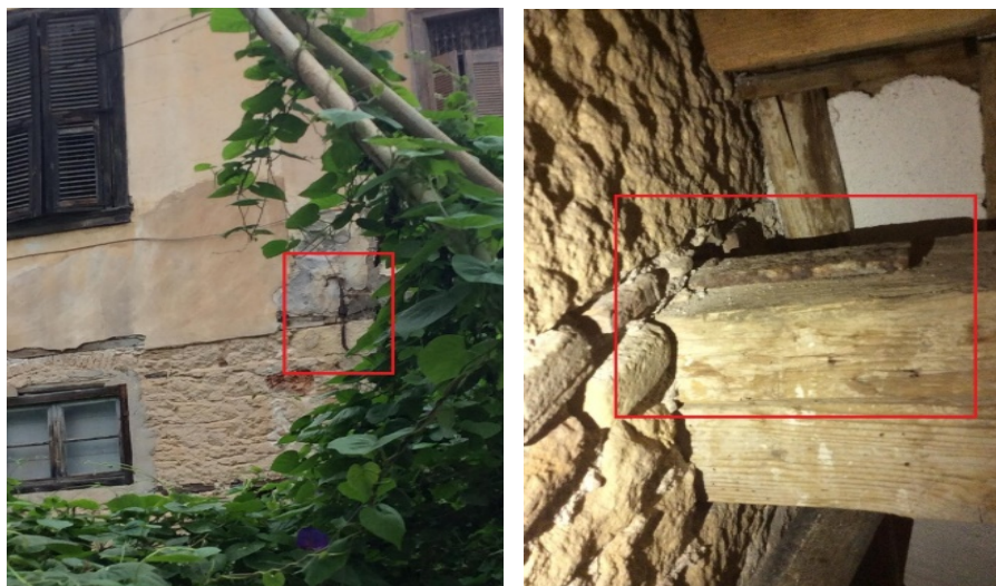
Εικόνα 2.20 - Σύστημα σύνδεσης δοκού - νότιου τοίχου.
