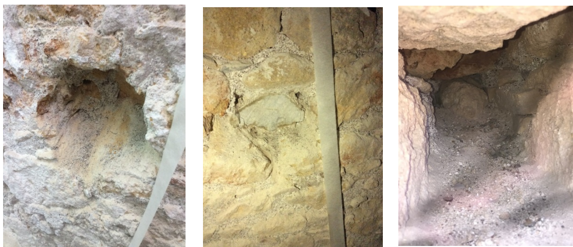
Εικόνα 4.2 - Τομές από την λήψη λίθων στις θέσεις 1,3 και από οπή του βόρειου τοίχου.
