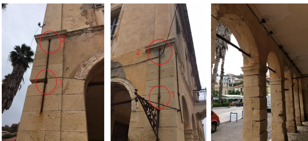
Εικόνα 2.10 - Θέσεις αγκύρωσης μεταλλικών στοιχείων 1,2: (α) βόρεια όψη, (β) νότια όψη, (γ) διαδρομή ελκυστήρα 1 διαμέσων των τόξων.
