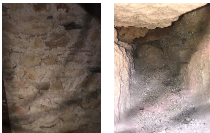
Εικόνα 2.2 - Απεικόνιση τριστρωτης αργολιθοδομής και κατά πάχος τομή .
