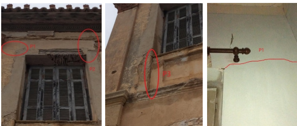
Εικόνα 3.1 - Φωτογραφική απεικόνιση ρωγμών ανατολικού τοίχου: (α) P1,2, (β) P3, (γ) P1 εσωτερικά.
