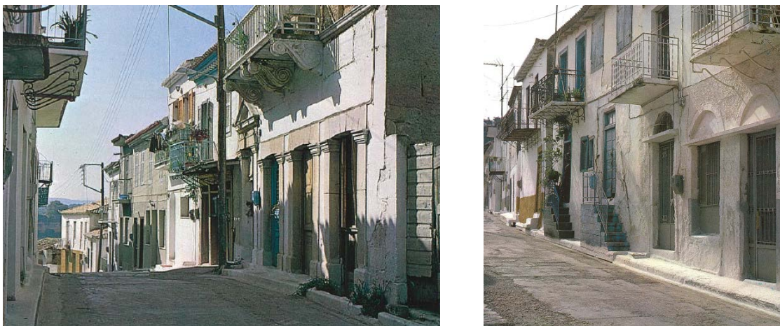
Εικόνα 1.5 - Άποψη δρόμων Κορώνης, όπου διακρίνονται οι απλές επίπεδες όψεις και τα μπαλκόνια με τις σιδερίες τους.
