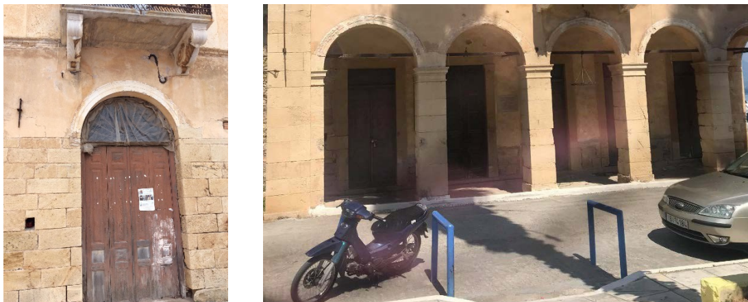
Εικόνα 2.3 - Απεικόνιση λαξευμένης λιθοδομής ανατολικού και βόρειου τοίχου.
