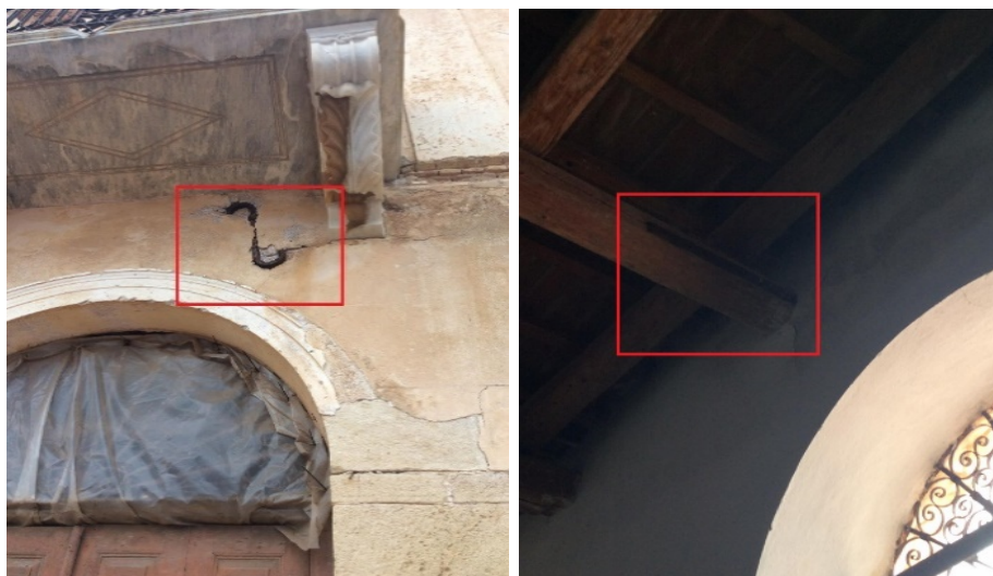
Εικόνα 2.19 - Σύστημα σύνδεσης δοκού - ανατολικού τοίχου.
