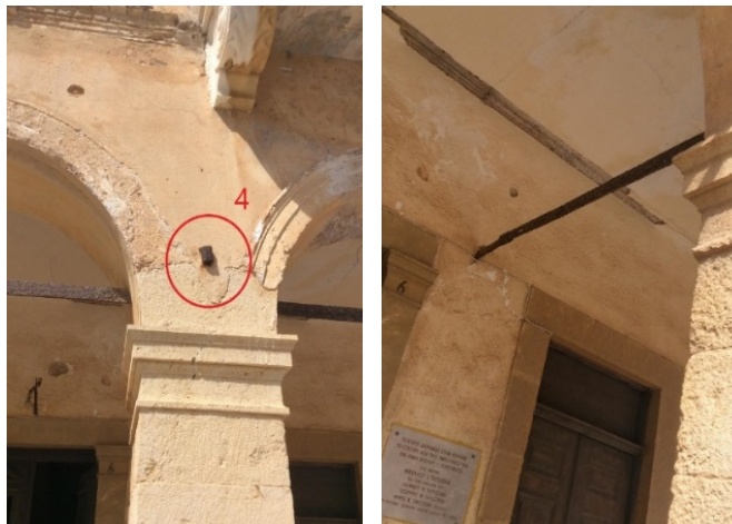
Εικόνα 2.15 - (α) Θέση αγκύρωσης μεταλλικού στοιχείου 4 ανατολική όψη, (β) διαδρομή
