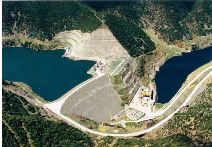
Εικόνα 1.4: Ο αντλητικός σταθμός στη θέση Σφηκιά (Αργυράκης Ι.,ΔΕΗ)
