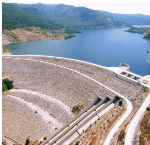
Εικόνα 1.5: Ο αντλητικός σταθμός στη θέση Θησαυρός (Αργυράκης Ι.,ΔΕΗ)
