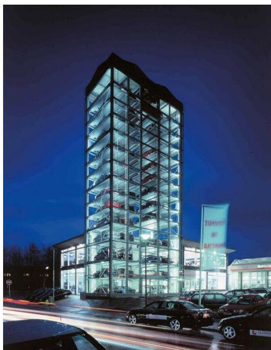
Εικόνα 60: Έξυπνο σύστημα πάρκινγκ – Tower Parking System
