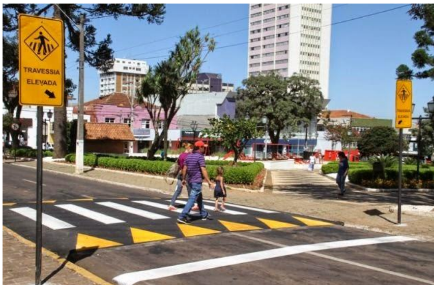
Εικόνα 52: Παράδειγμα υπερυψωμένης διάβασης στη Σάο Πάολο, Βραζιλία Πηγή: https://www.mestresdotransito.com.br/2014/07/aula-13-faixa-elevada-para-travessia-de.html
