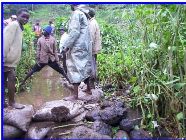
Σχήμα 3.24: Σχηματισμός της μικρής λίμνης από βράχους και από σάκους με λάσπη
