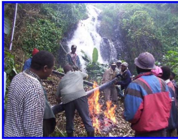
Σχήμα 3.28: Θέρμανση τμημάτων του αγωγού νερού με τη βοήθεια φωτιάς
