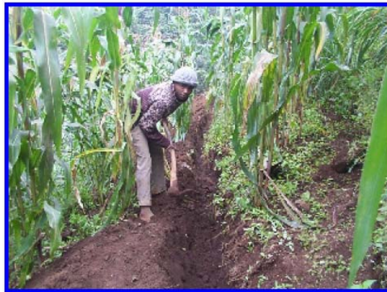
Σχήμα 3.15: Χαντάκι τοποθέτησης του αγωγού
