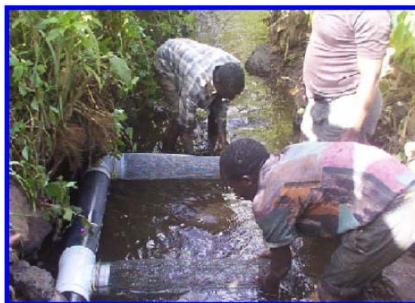
Σχήμα 3.25: Το συρμάτινο δίχτυ πάχους 5mm που λειτουργεί ως φίλτρο
