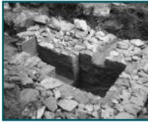
Σχήμα 3.3: Είσοδος νερού-δεξαμενή κατά την φάση της κατασκευής
