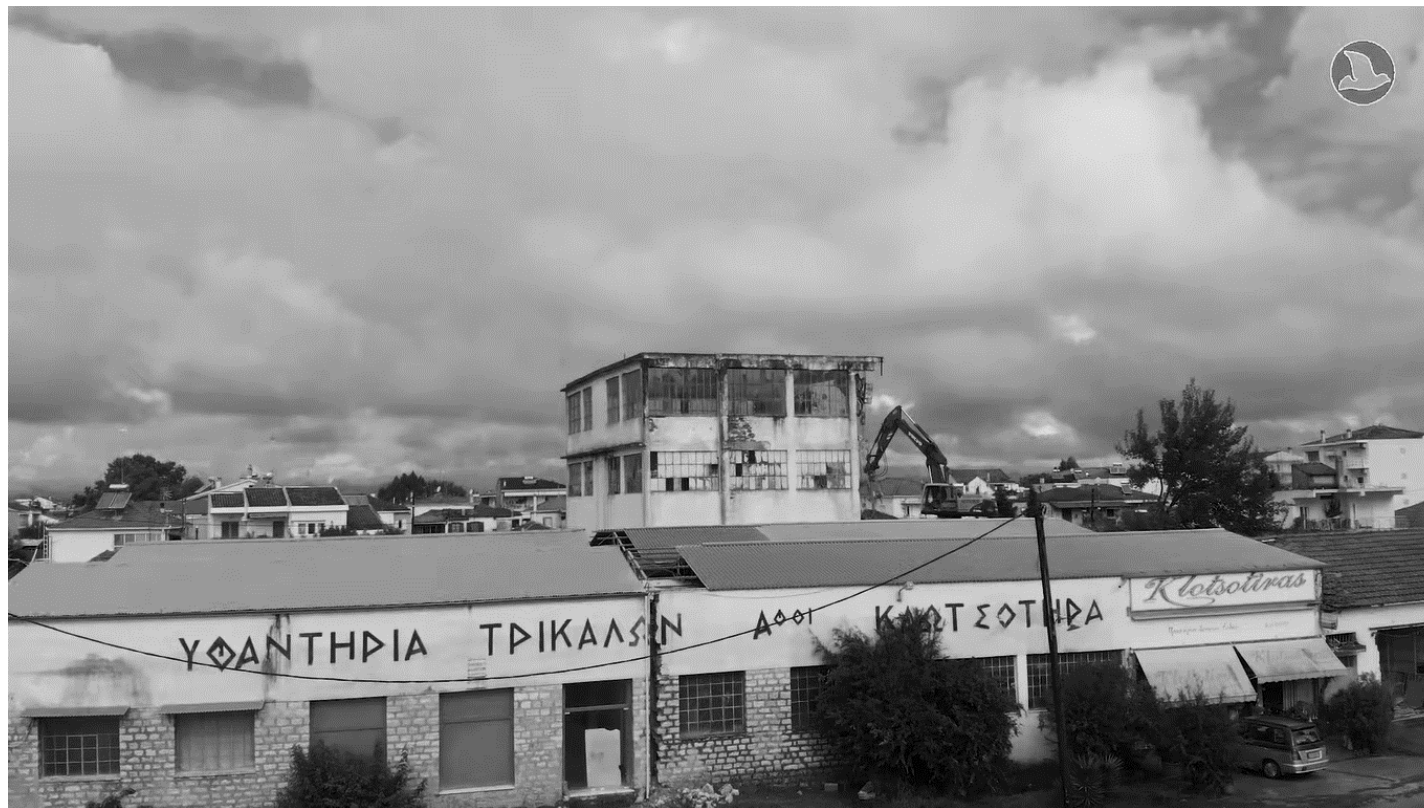
Κατά την διάρκεια της κατεδάφισης του τριόροφου κτιρίου
