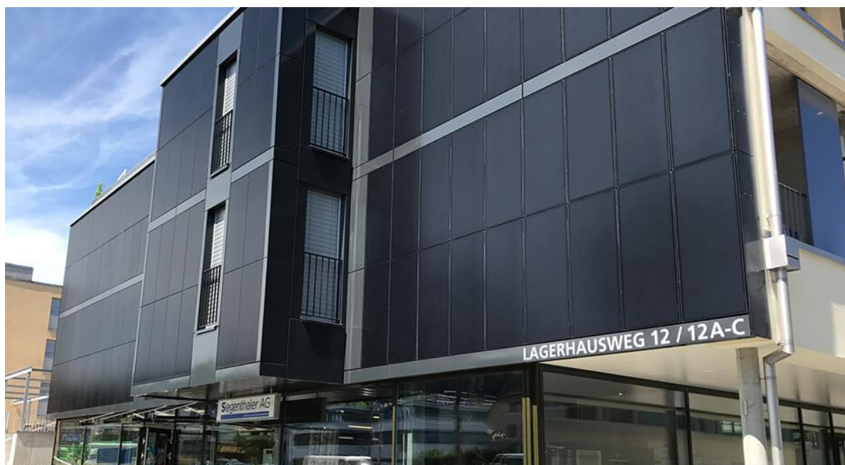
Σχήμα 2.13 Κτήριο με ενσωματωμένη φωτοβολταϊκή πρόσοψη [25]
