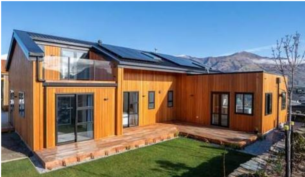
Σχήμα 2.10 Κτηριακή μονάδα, κατασκευασμένη με δομικά μονωτικά πλαίσια (SIPS) [19]
