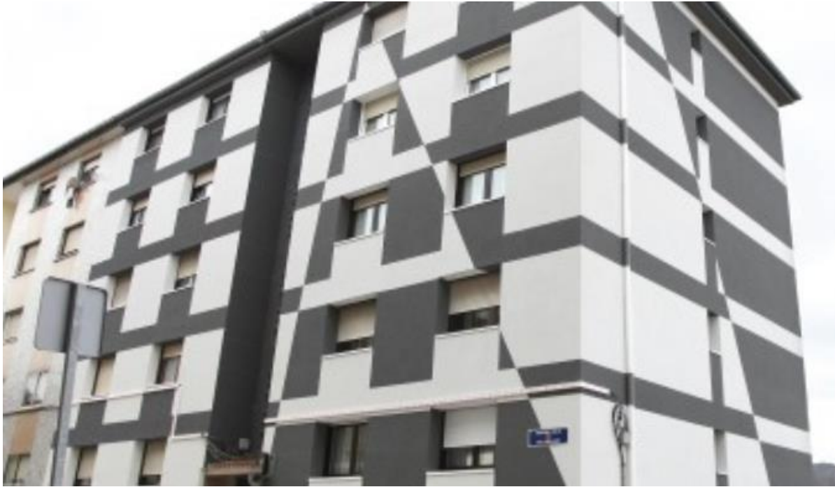
Σχήμα 2.5 Πρόσοψη κτηρίου, κατασκευασμένη με σύστημα ETICS [12]
