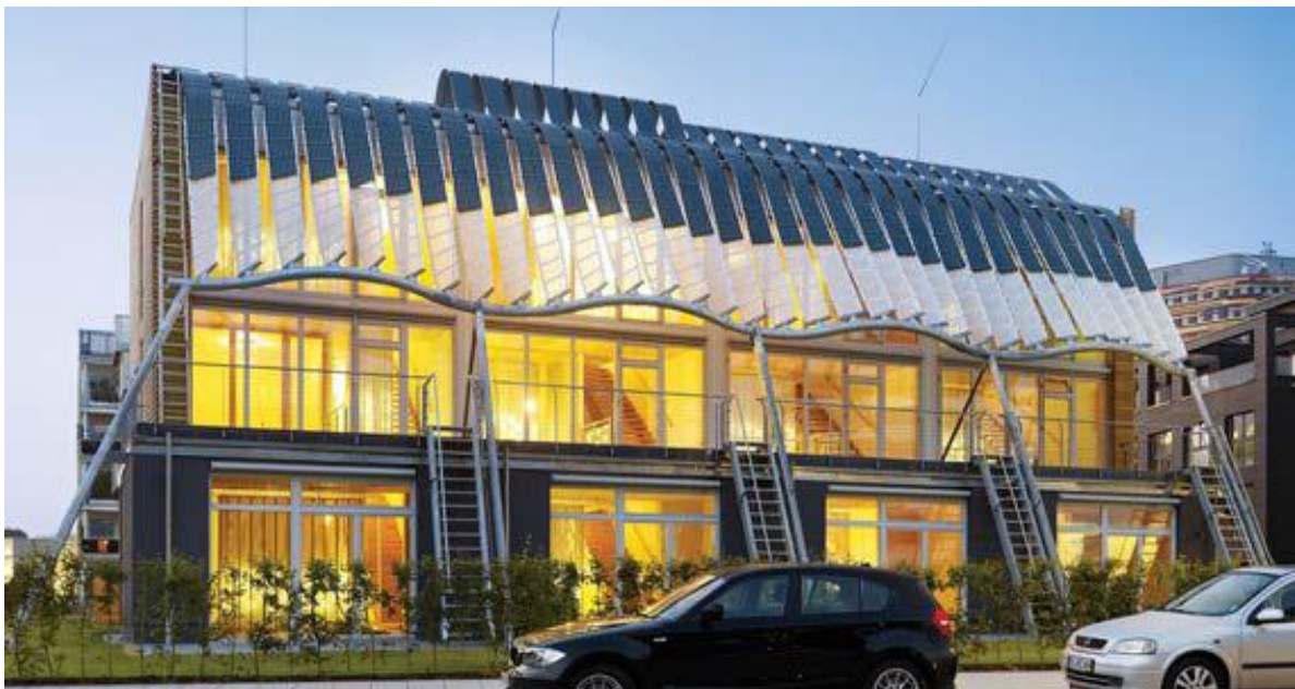
Σχήμα 2.14 Κτήριο με δυναμικό φωτοβολταϊκό σύστημα πρόσοψης [26]
