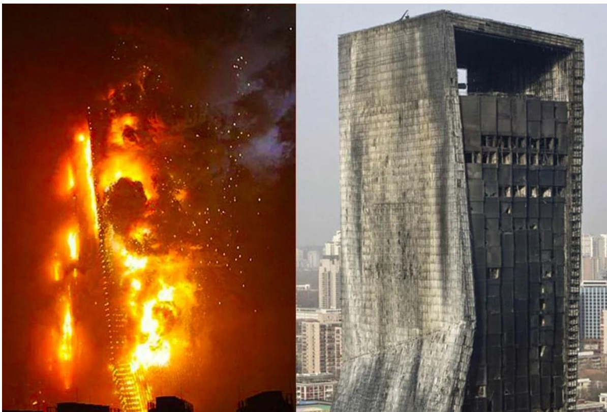
Σχήμα 3.4 Το κτήριο TVCC κατά τη διάρκεια της φωτιάς και μετά την κατάσβεσή της [37]
