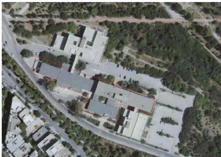
Εικόνα 4.2: Κτήριο Λαμπαδαρίου της ΣΑΤΜ-ΜΓ ΕΜΠ
