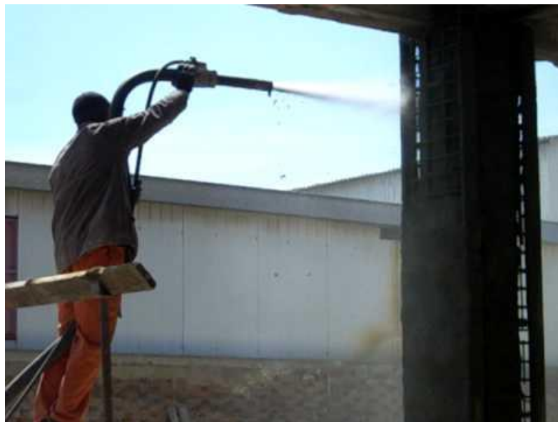
Εικόνα 5.6-Προετοιμασία εργασιών και εκτόξευση σκυροδέματος (gunite)
