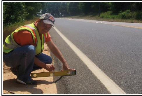
Εικόνα 2.6.: Παράδειγμα από την τεχνολογία Safetyedge
