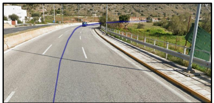
Εικόνα 4.23.: Απεικόνιση της περιοχής (2 ο οδικό δίκτυο) με το εργαλείο Street View
