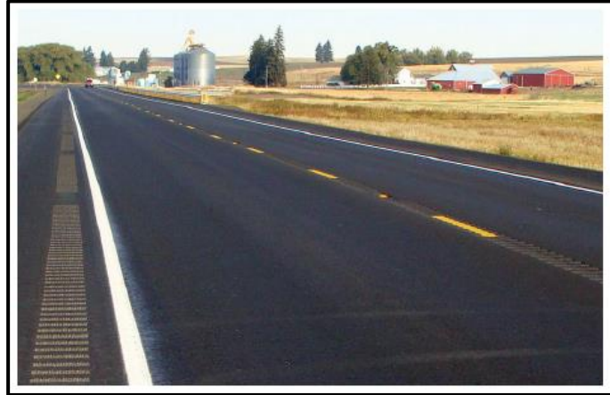
Εικόνα 2.1: Λωρίδες θορύβου στο κέντρο του οδοστρώματος και στο έρεισμα.
