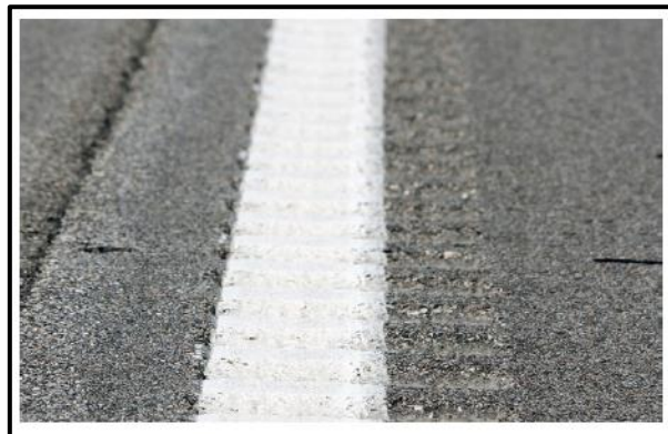
Εικόνα 2.2: Παράδειγμα λωρίδας θορύβου στην άκρη του οδοστρώματος.
