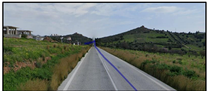
Εικόνα 4.70.: Απεικόνιση των δυο κατευθύνσεων της λεωφόρου Αθηνών – Σουνίου με το εργαλείο Street View, 23° οδικό τμήμα
