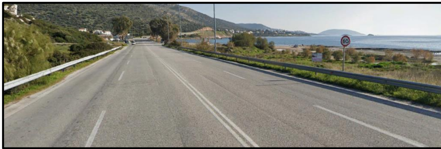
Εικόνα 4.40.: Απεικόνιση των δυο κατευθύνσεων της λεωφόρου Αθηνών – Σουνίου με το εργαλείο Street View, 8 ο οδικό τμήμα.
