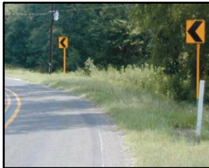
Εικόνα 2.5: Πινακίδες Chevrons που είναι αντανακλαστικές και είναι εγκατεστημένες σε στόλους.
